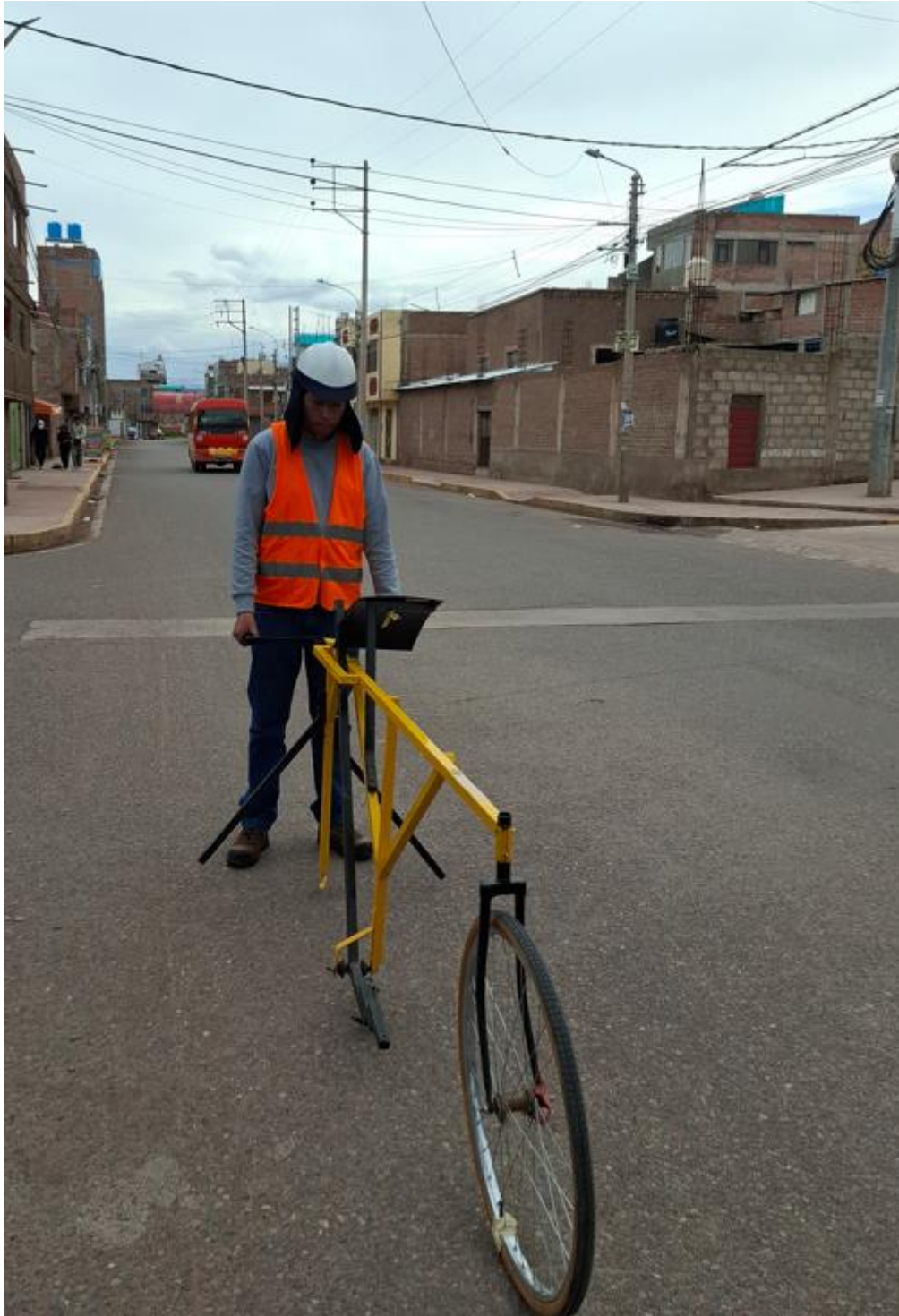
FOTOGRAFÍA 04 – CONTEO DE IRI MARGEN IZQUIERDO PROG 0+800 AL 1+000
