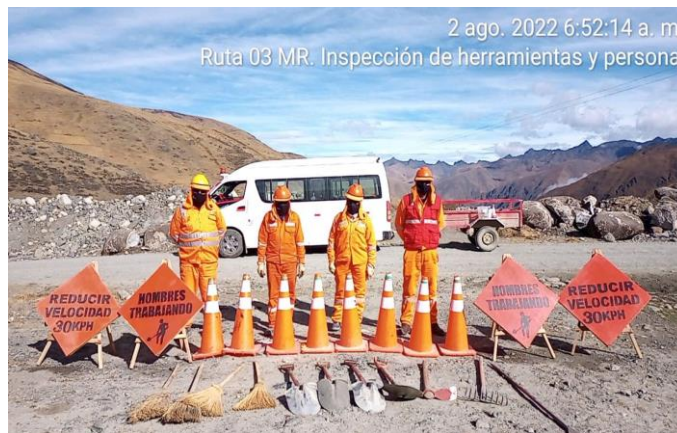
Nota. Inspección de herramientas y equipos de protección colectiva
