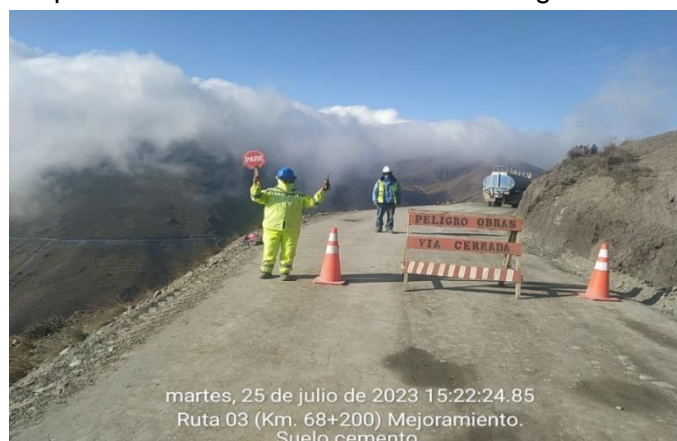
Fotografía 18. Dispositivos de control de tránsito con vigías
