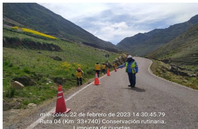
Fotografía 21. Uso de conos de seguridad en trabajos de conservación rutinaria
