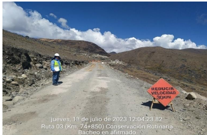
Fotografía 19. Señalización preventiva temporal en trabajos de conservación
