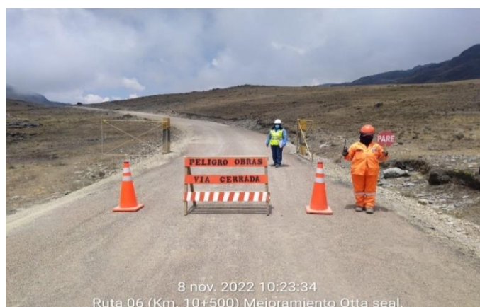
Fotografía 17. Dispositivos de control de tránsito con vigías
