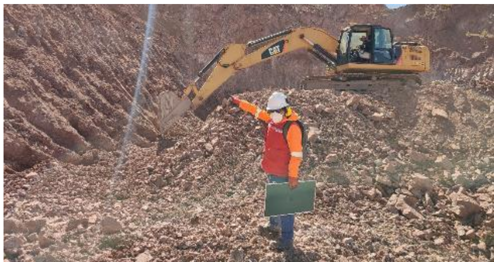
Figura 11: Extracción de material.
