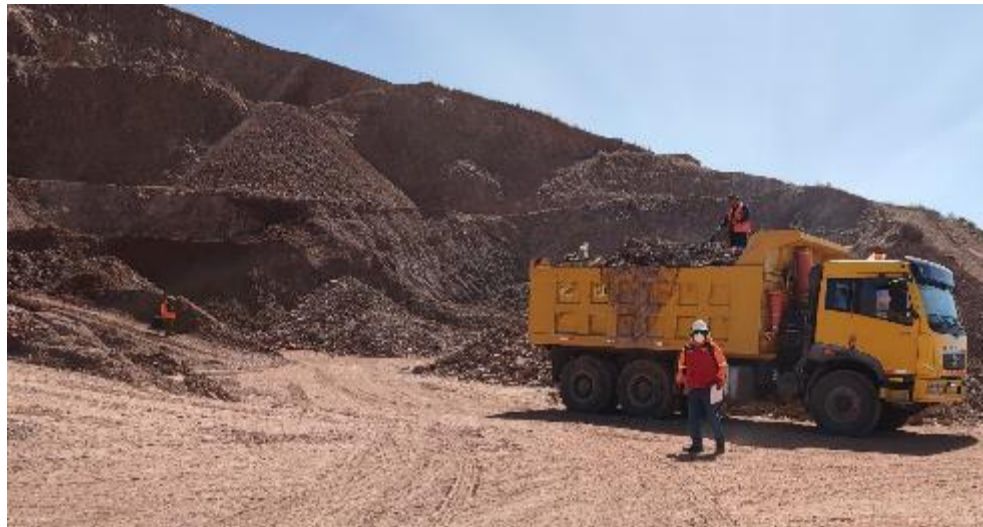
Figura 15: Carguío de material extraído.
