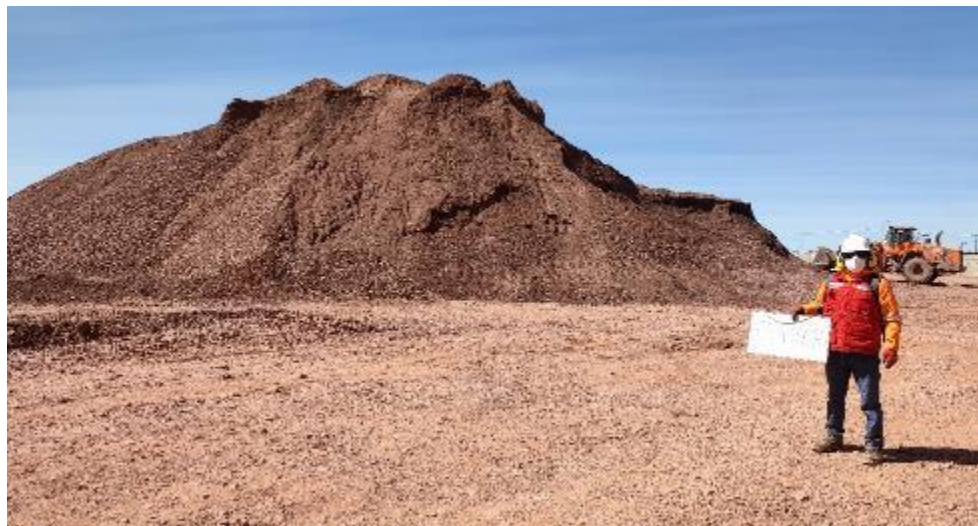
Figura 14: Apilamiento de material extraído.
