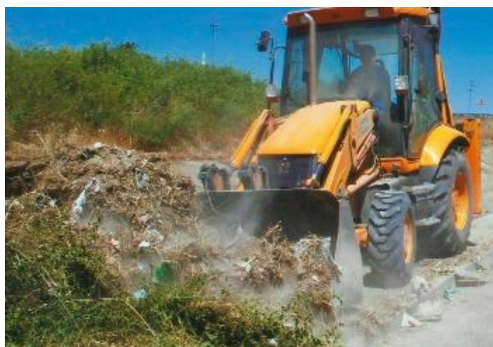
Figura 7: Limpieza y desbroce.
