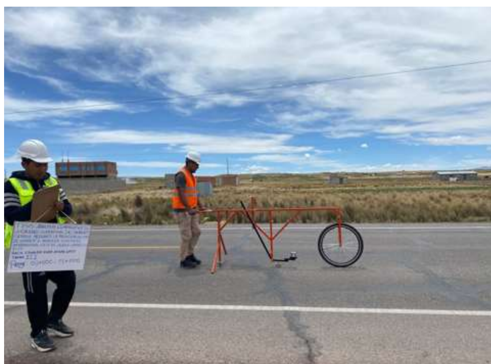
Fotografía 8. Evaluación del IRI en el tramo 14
