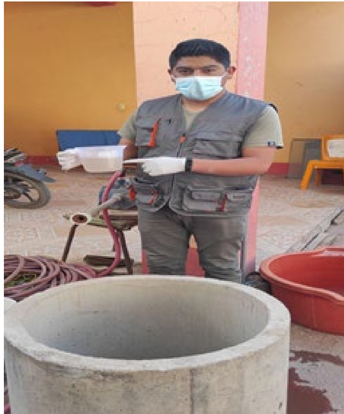
Fotografía 1. Identificación de las características y componentes estructurales del pozo domésticos construido en la Urbanización Santo Tomas
