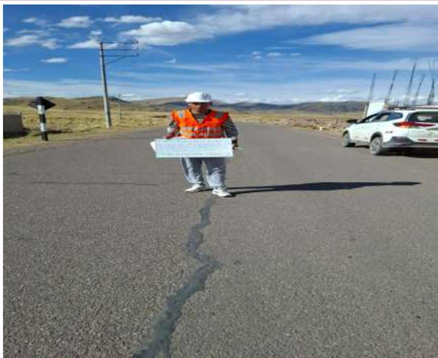
Fotografía 9. Tramo – 5 (LAMPA - PUCARA)
