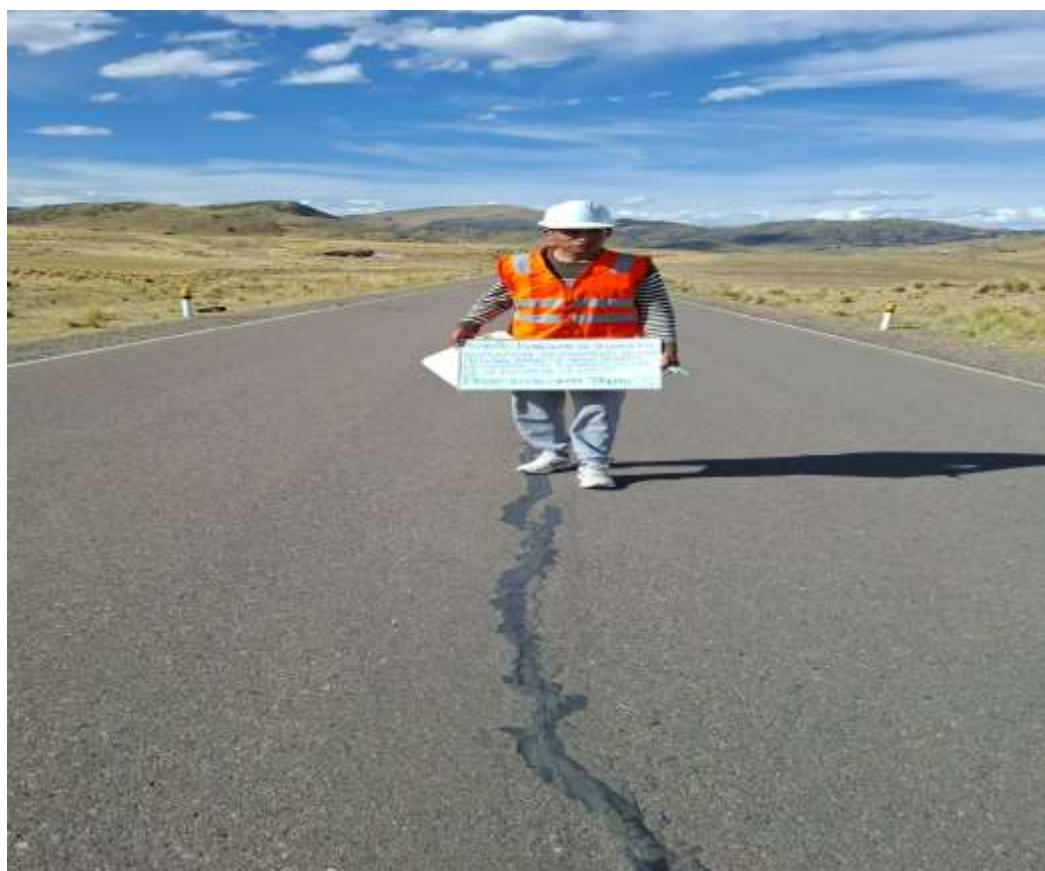
Fotografía 10. Tramo – 5 (LAMPA - PUCARA)
