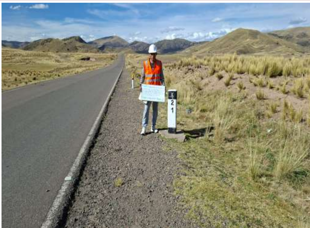
Fotografía 11. Tramo – 6 (LAMPA - PUCARA)
