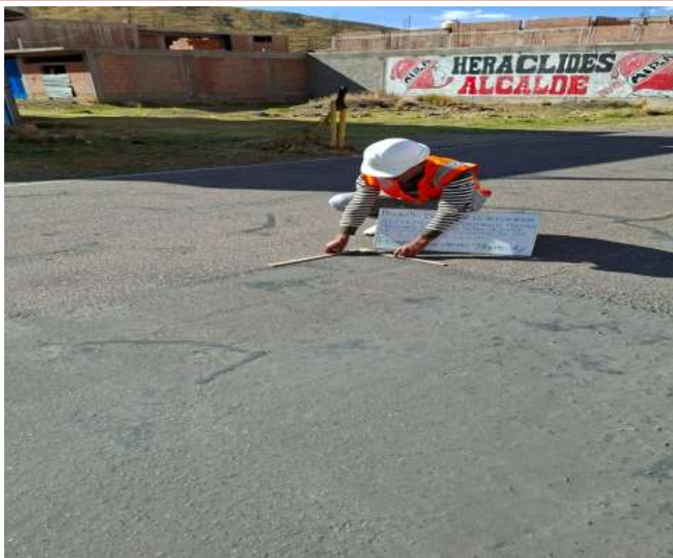
Fotografía 7. Tramo – 4 (LAMPA - PUCARA)
