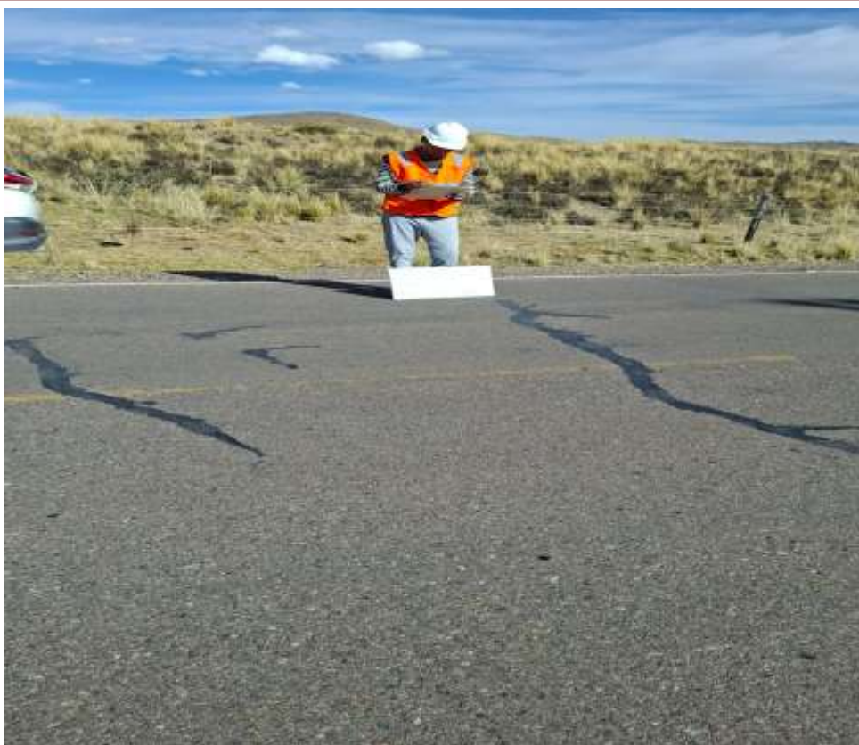
Fotografía 15. Tramo – 8 (LAMPA - PUCARA)
