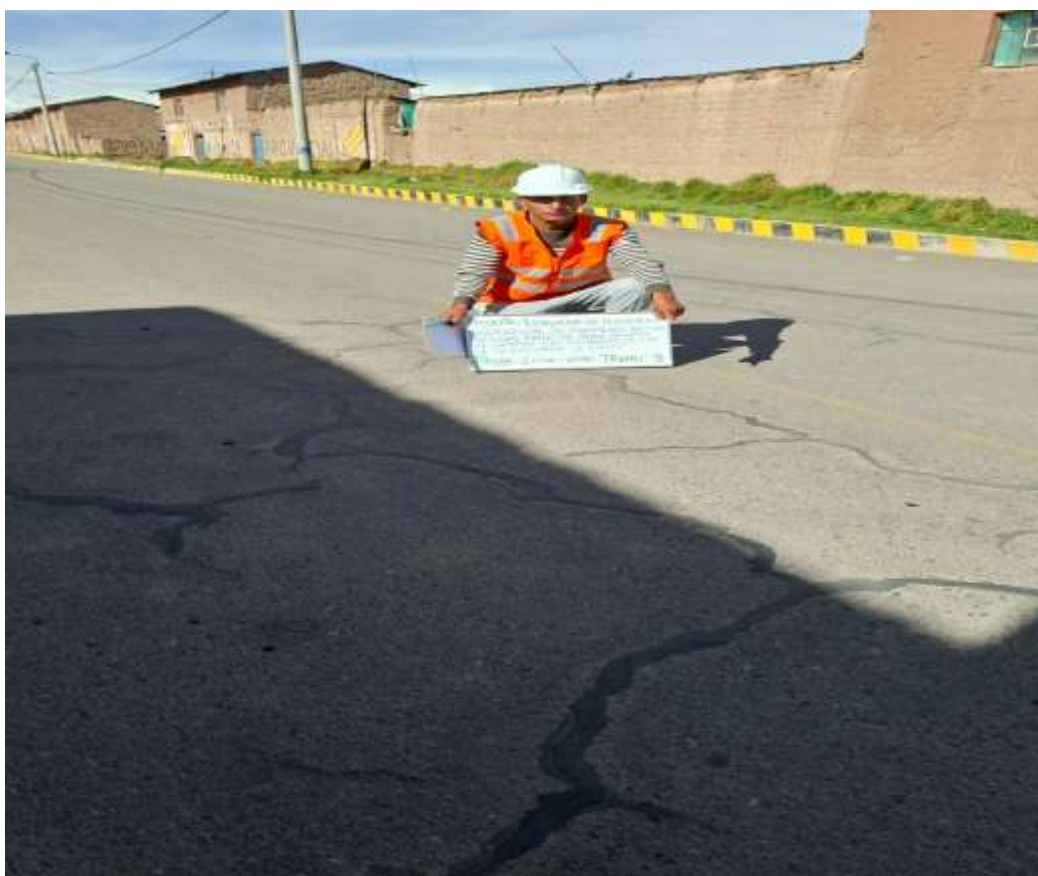
Fotografía 6. Tramo – 3 (LAMPA - PUCARA)
