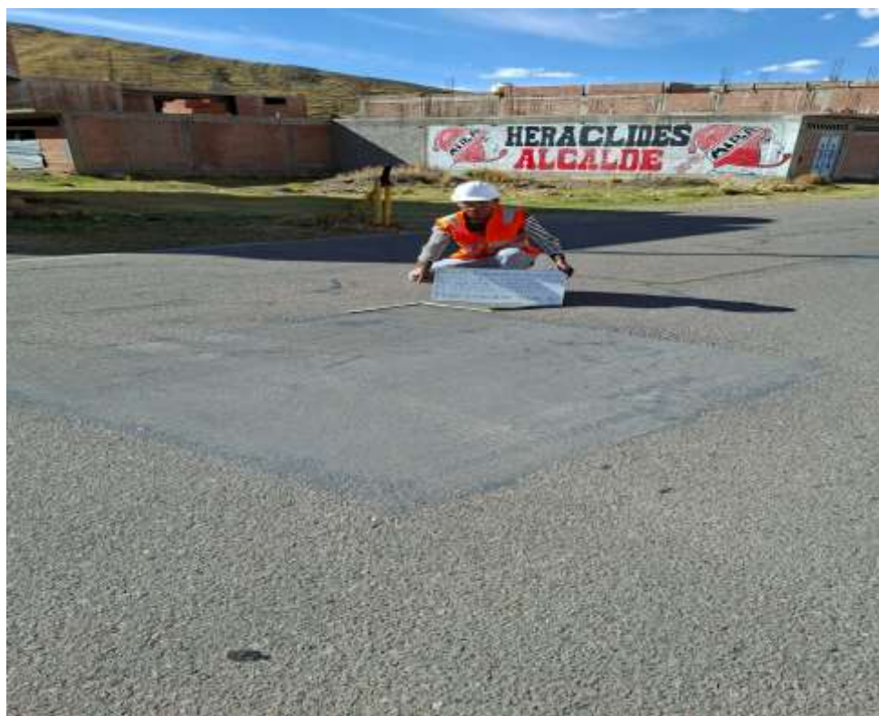
Fotografía 8. Tramo - 4 (LAMPA - PUCARA)
