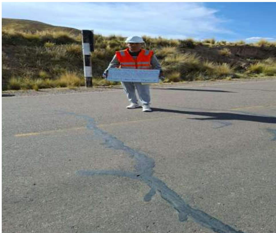
Fotografía 16. Tramo - 8 (LAMPA - PUCARA)
