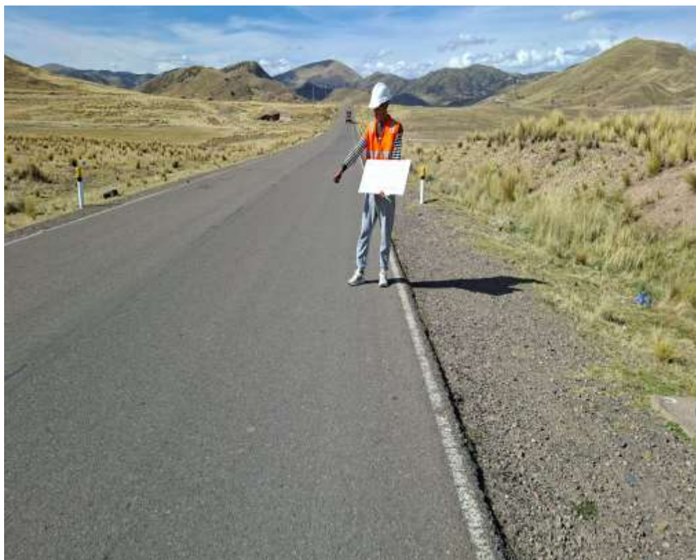
Fotografía 12. Tramo – 6 (LAMPA - PUCARA)
