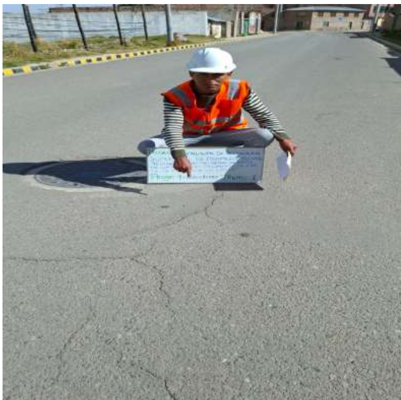
Fotografía 2. Tramo – 1 (LAMPA - PUCARA)
