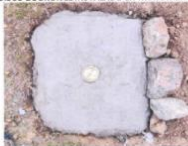
f. IMAGEN DEL DISCO DE BRONCE INSTALADO EN MONUMENTO TERMINADO
