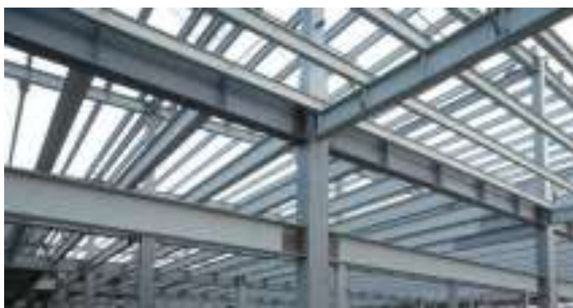
Armadura de acero
