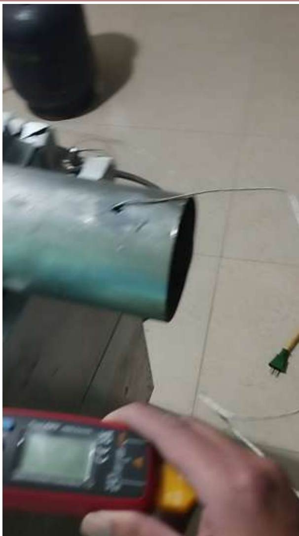
Fotografía 9. Vista del ducto de aire.
