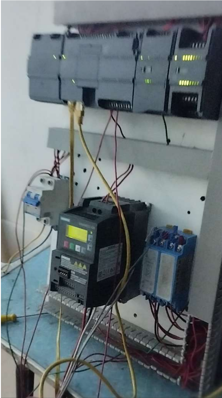
Fotografía 4. Vista del tablero.
