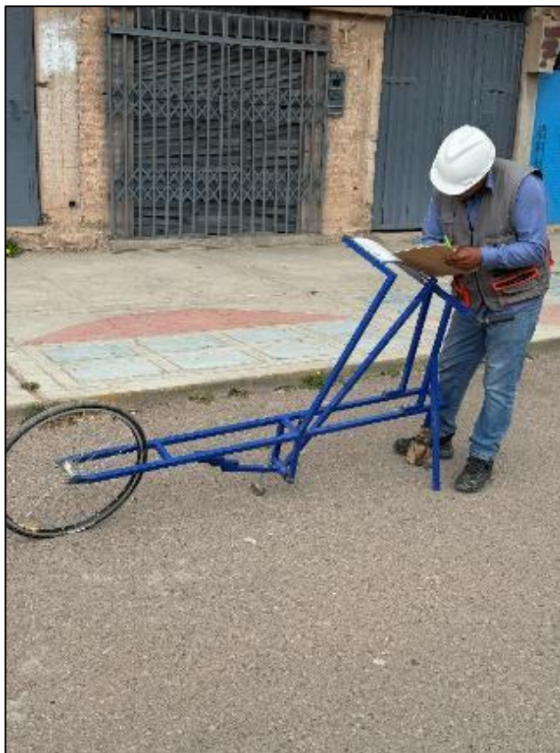
Fotografía 17. Registro de datos de la sección de la calzada 2.
