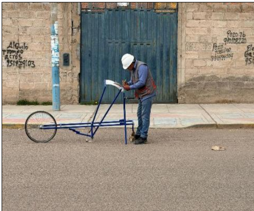
Fotografía 12. Registro de datos de la sección de la calzada 1.
