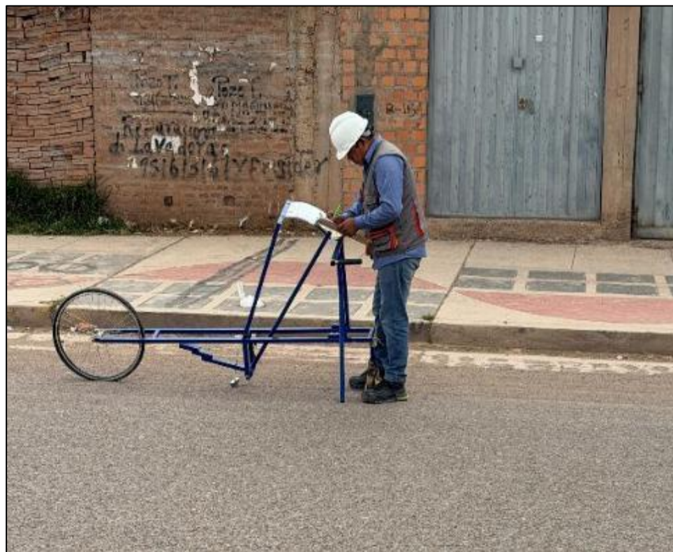
Fotografía 22. Depresiones y deflexiones en la sección de la calzada 2.
