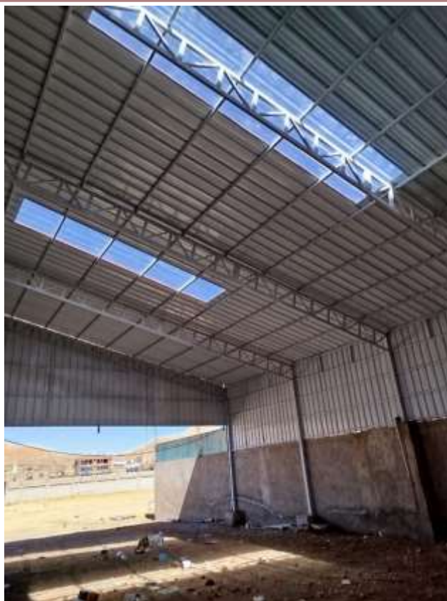
Figura 3. Vista del techado de la estructura metálica
