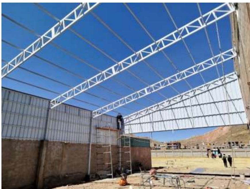
Vista previa antes del techado de la estructura metálica
