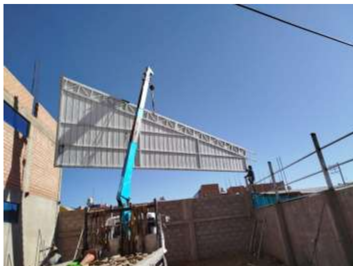
Vista de apoyo logístico e grúa para el techado de la estructura metálica
