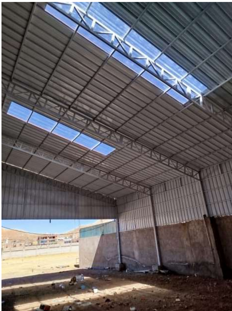
Vista del techado de la estructura metálica
