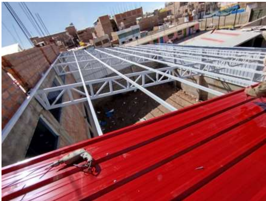
Vista del techado de la estructura metálica
