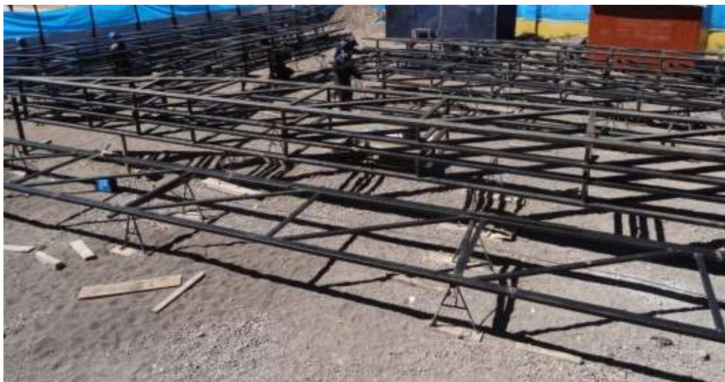
Vista del armado de la estructura metálica
