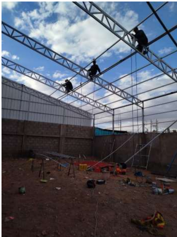
Vista de operarios antes del techado de la estructura metálica
