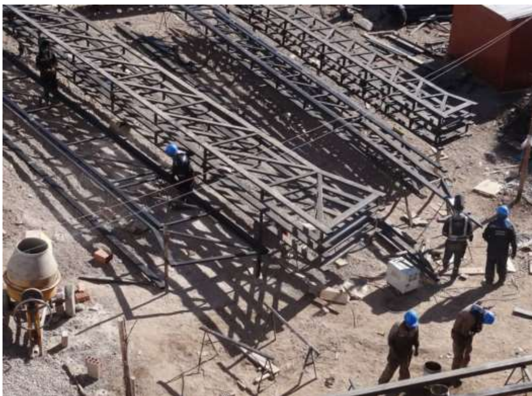
Vista del equipo de trabajo en el armado de la estructura metálica
