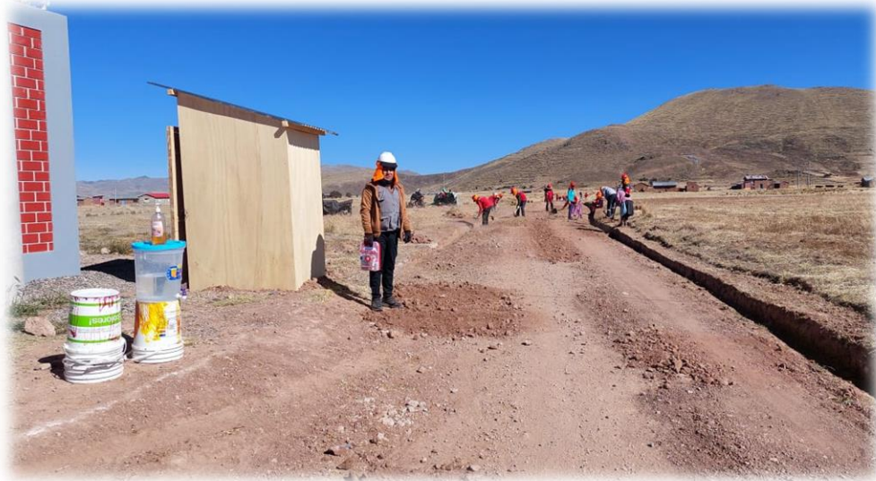
Vista panorámica de la ejecución de la obra
