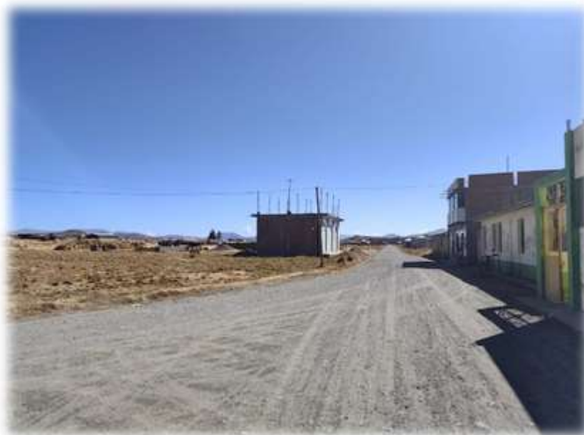
Vista de la vía de acceso a la Parcialidad de Sacasco
