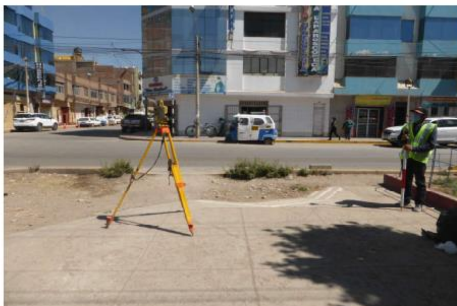
Av. Circunvalación Este detallamiento de la berma central.
