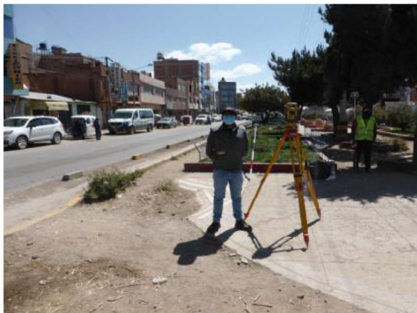
Inicio del proyecto en la intersección Av. Circunvalación Este con Jirón Sucre, Estación E-1.
