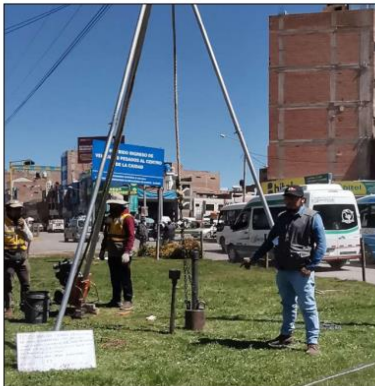
Extracción de muestra del suelo de calicata C-1 en el eje de Estribo Izquierdo.
