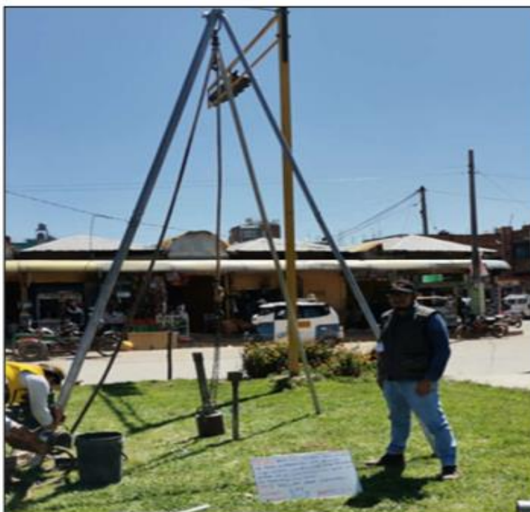
Ejecución del ensayo de penetración estándar (STP) ASTM D-1586.
