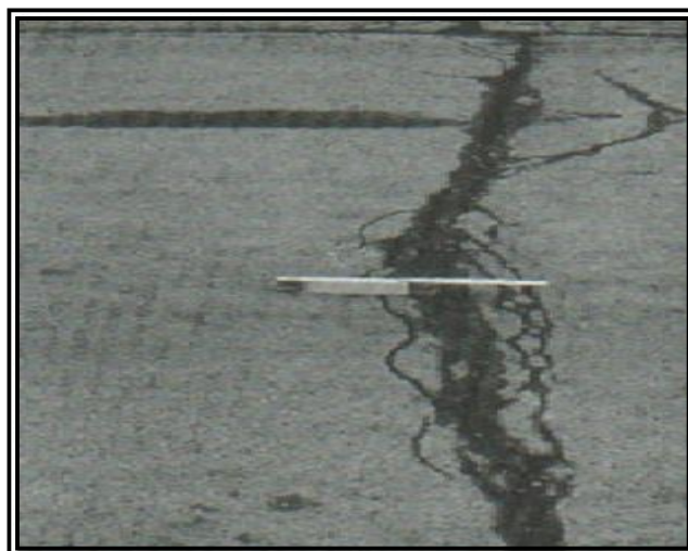
Figura 32: Grieta alta severidad.
