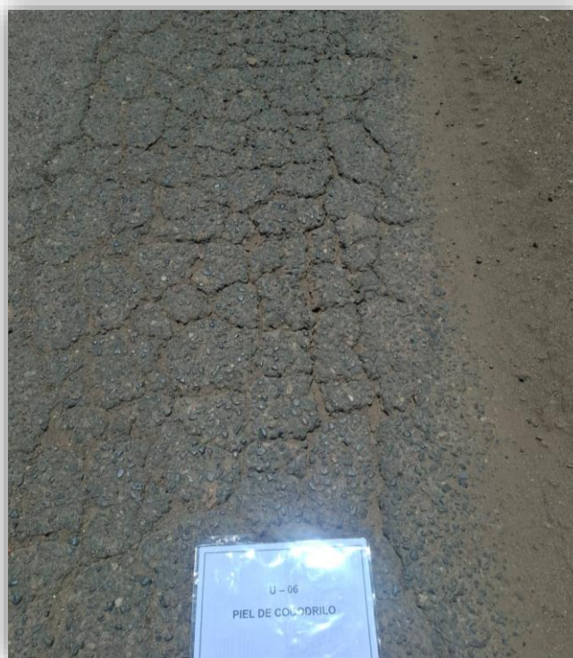
Figura 71: Falla tipo piel de cocodrilo representativa U-06.
