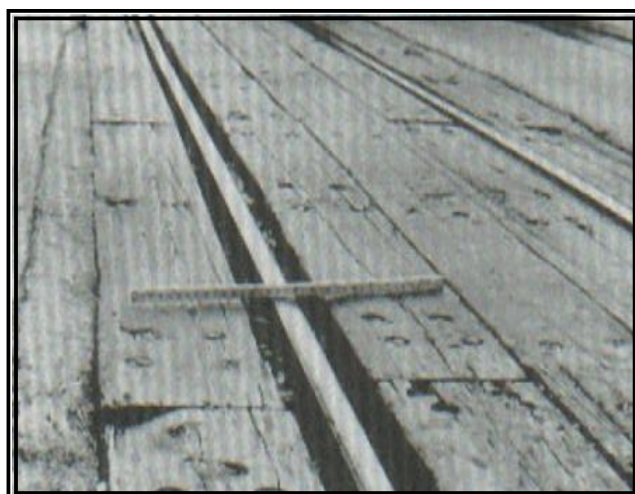
Figura 47: Cruce de riel: severidad alta.
