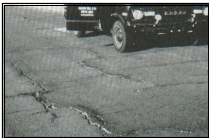
Figura 17: Grietas alta severidad.
