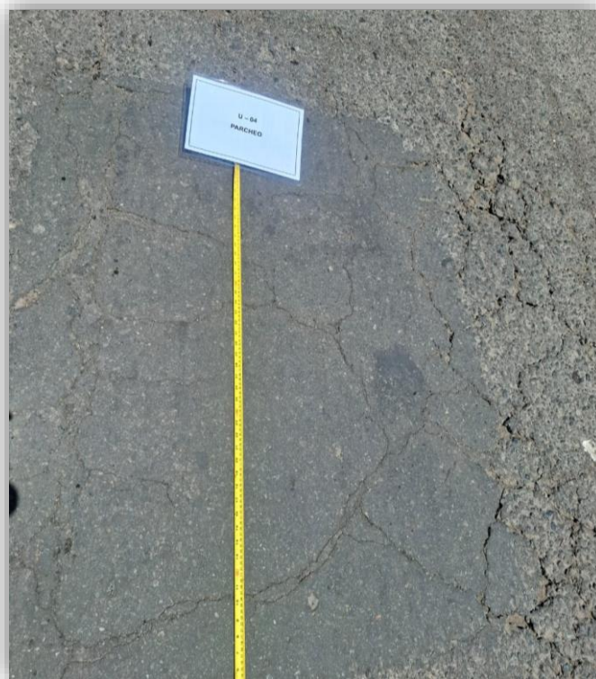
Figura 69: Falla tipo parcheo representativa U-04.
