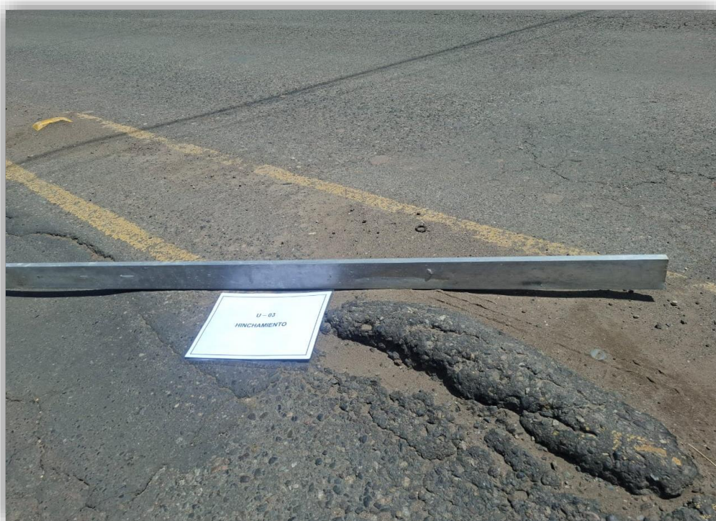
Figura 68: Falla tipo hinchamiento representativa U-03.
