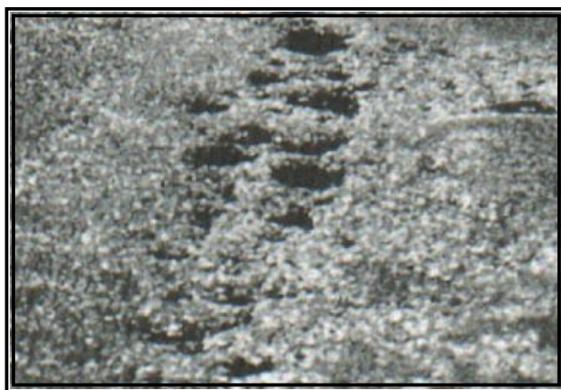
Figura 60: Desprendimiento de agregados: de alta severidad.
