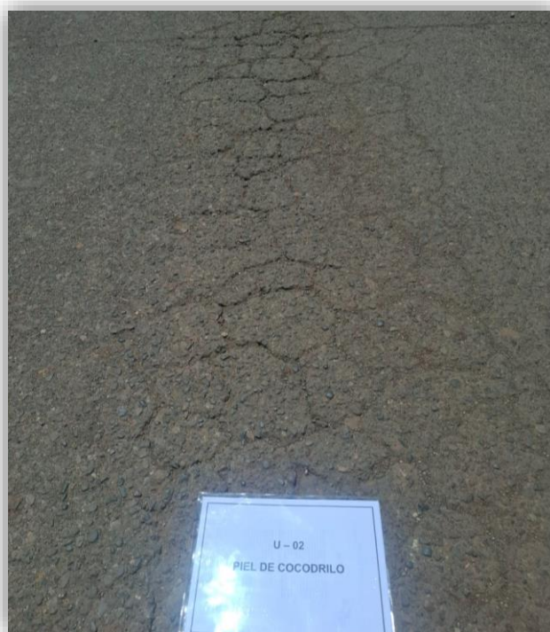
Figura 67: Falla tipo piel de cocodrilo representativa U-02.
