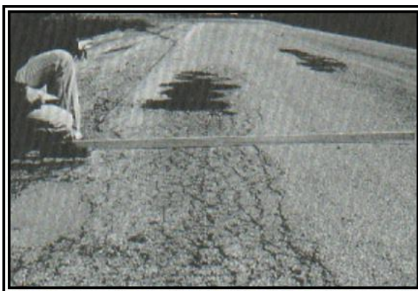
Figura 11: Piel con alta severidad.
