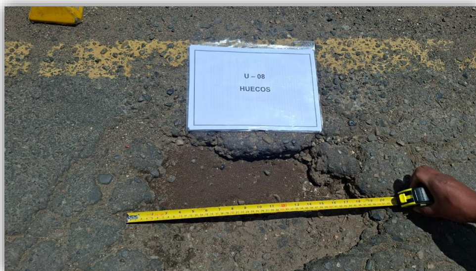
Figura 73: Falla tipo Huecos representativa U-08.
