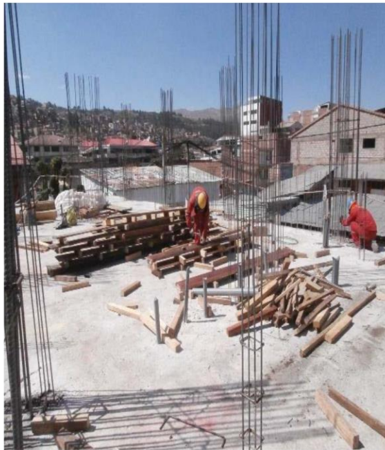
Traslado de los materiales para el inicio del encofrado de las columnas
