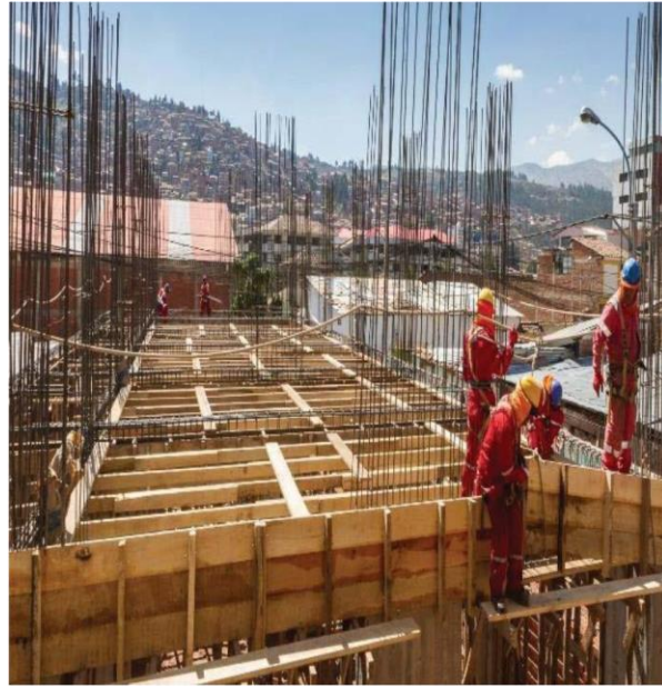
Encofrado de vigas, siempre manteniendo su nivel
