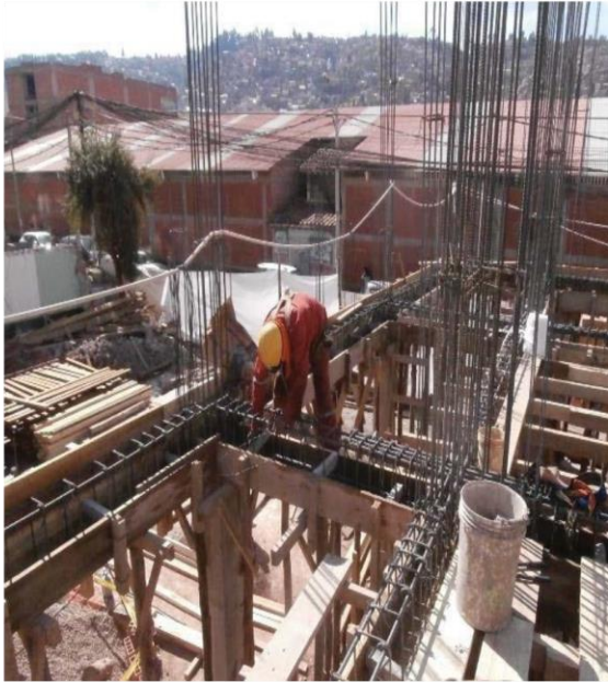
Encofrado de vigas
