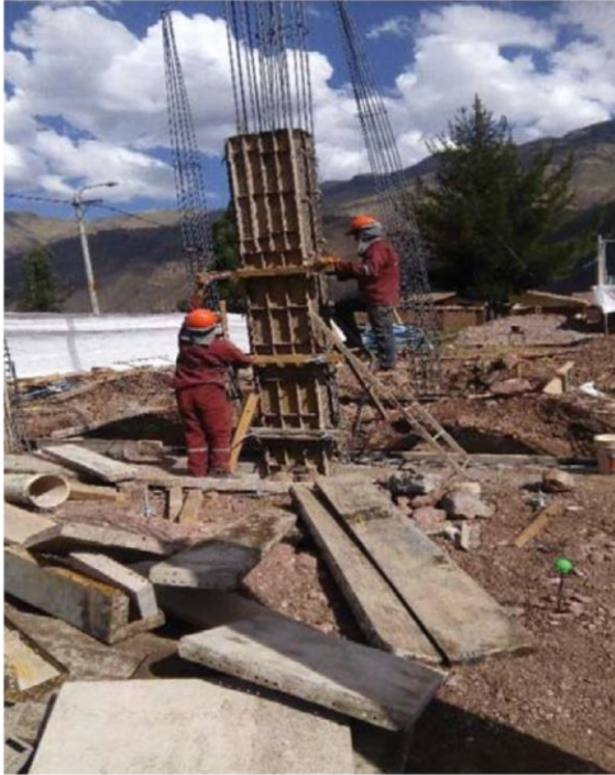
Enconfrado de columnas, ahí se observa la colocación de los barrotes
