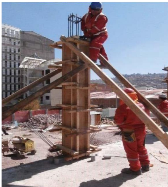
El encofrado de columna con sus respectivos puntales
