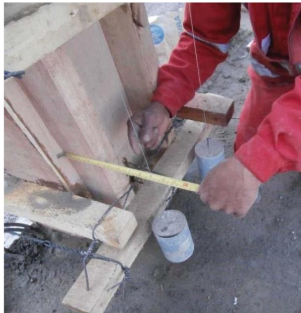
Se observa el aplomado del encofrado de la columna
