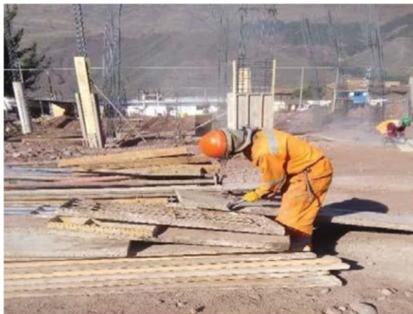
Limpieza de los paneles o formaletas
