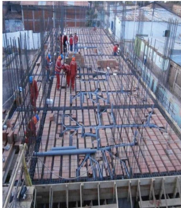
Encofrado de losa, colocando los ladrillos
