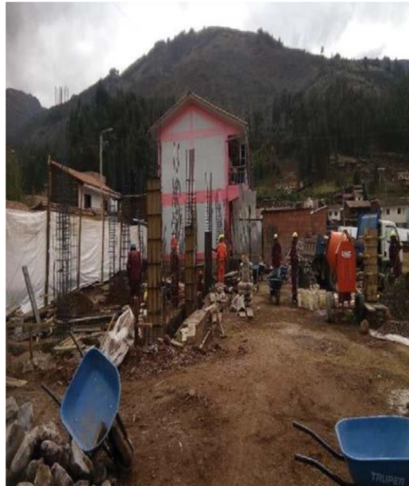
Panorama del bloque que se realiza el analisis del encofrado metalico
