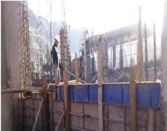
Encofrado de sobre cimientos, ya en proceso de vaciado
