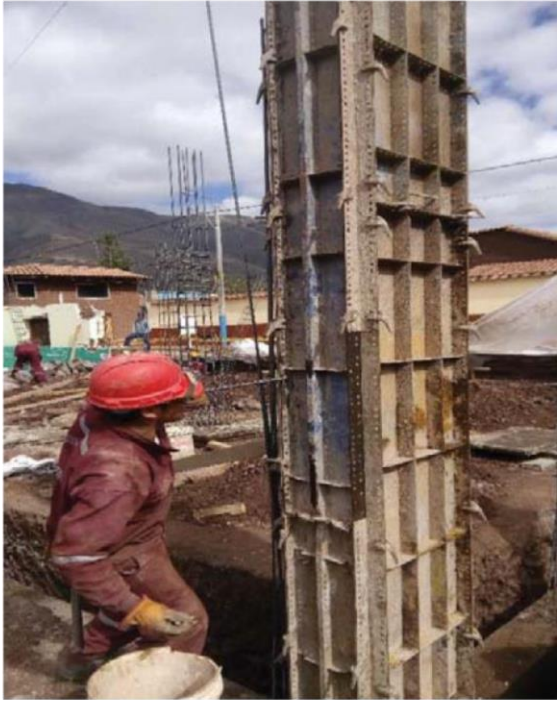
En la fotografía se observa el encofrado del cimiento corrido
