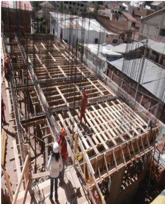
Encofrado de losa, colocando las tablas para el colocado de los ladrillos
