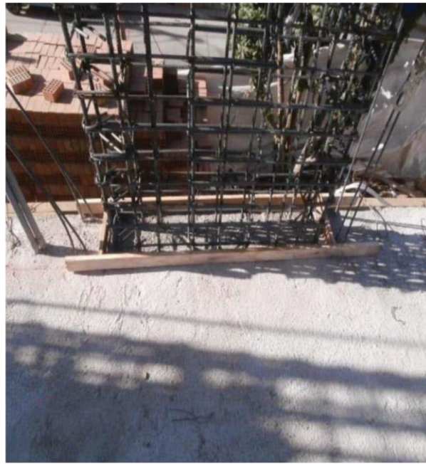
Se observa el inicio del encofrado de columnas
