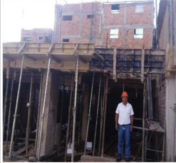
encofrado de losa
