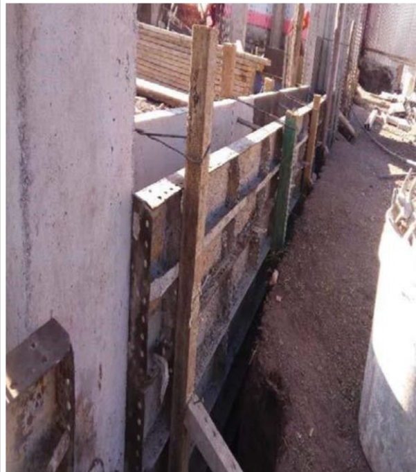
Encofrado sobre cimiento
