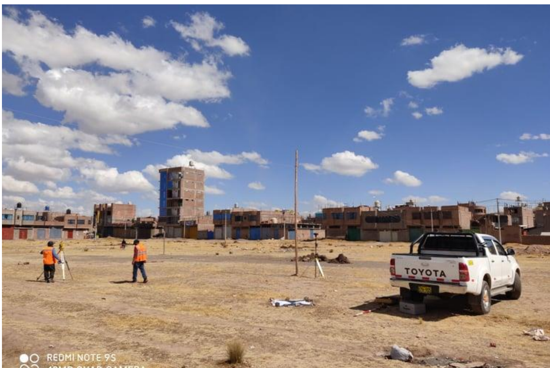
FOTOGRAFÍA 8: Trabajos de levantamiento topográfico en terrenos del centro educativo
