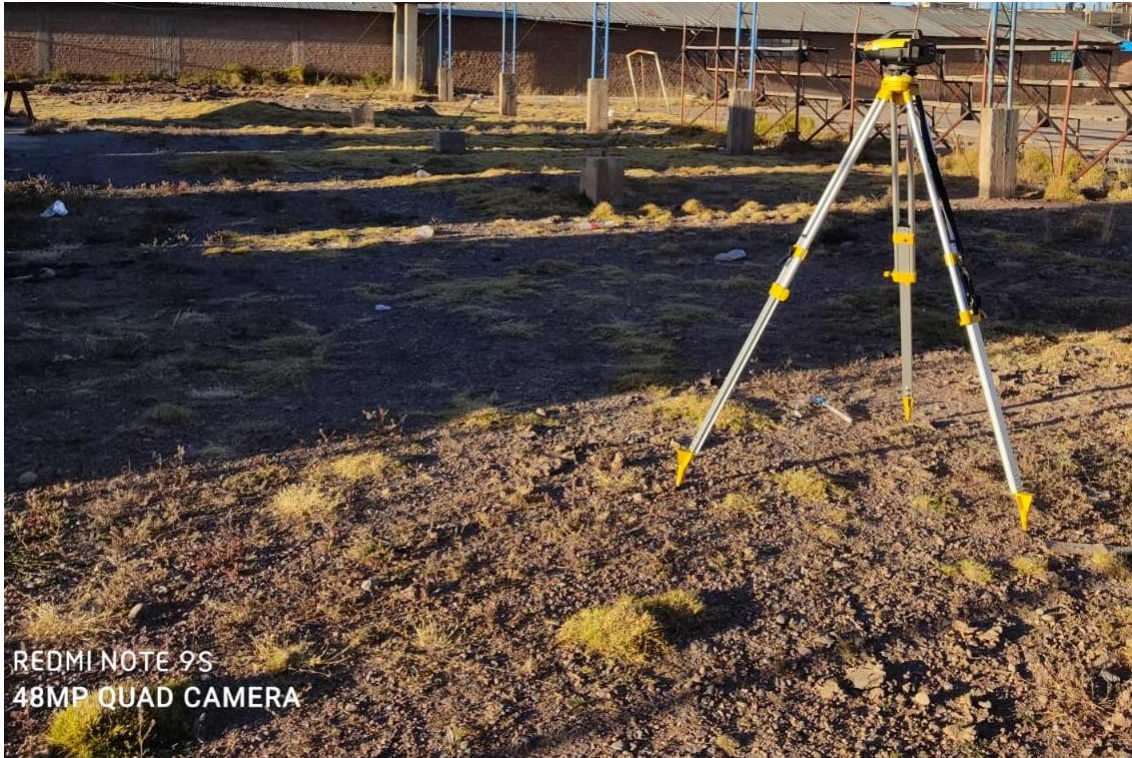
FOTOGRAFÍA 5: Lectura del nivel al primer Punto de estacionamiento
