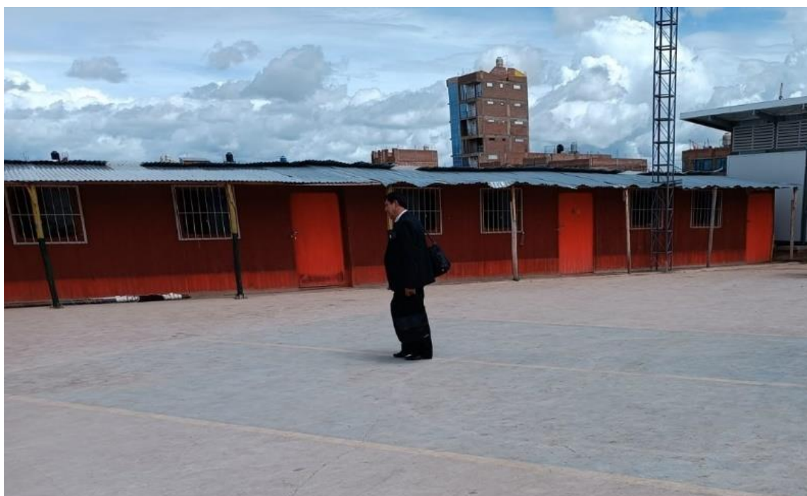
FOTOGRAFÍA 2: Aulas pedagógicas prefabricadas con madera y techo de calamina
