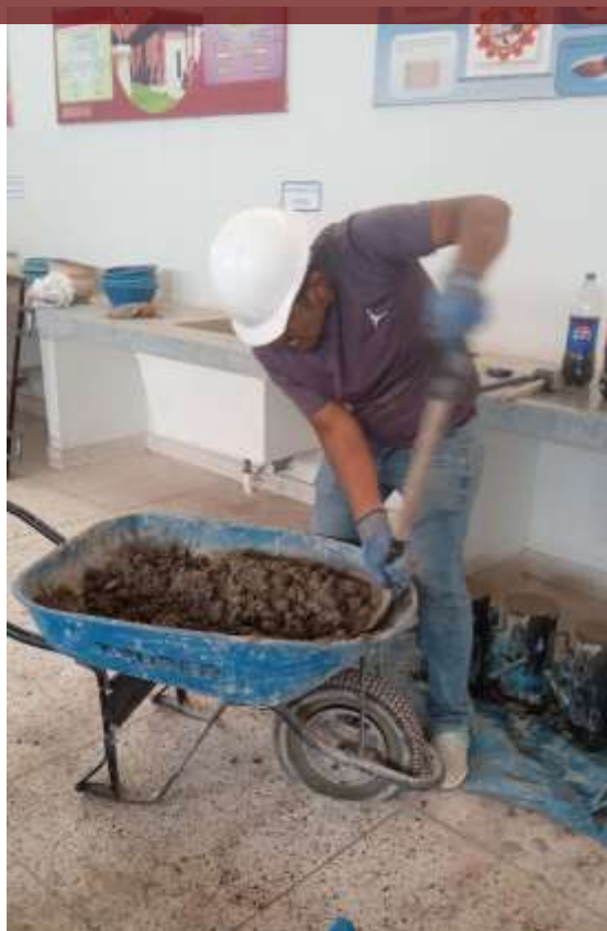
Fotografía 9. Mezcla de agregados, cemento y agua
