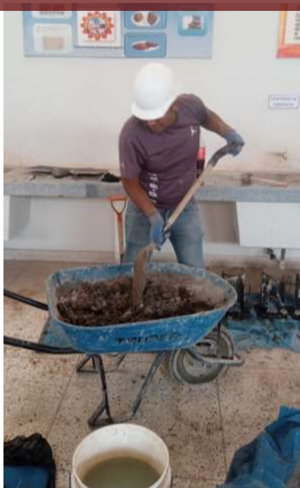
Fotografía 7. Mezcla de agregados y cemento
