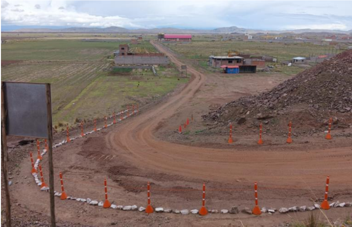
Fotografía 5. Señalización en vía para transporte de material.
