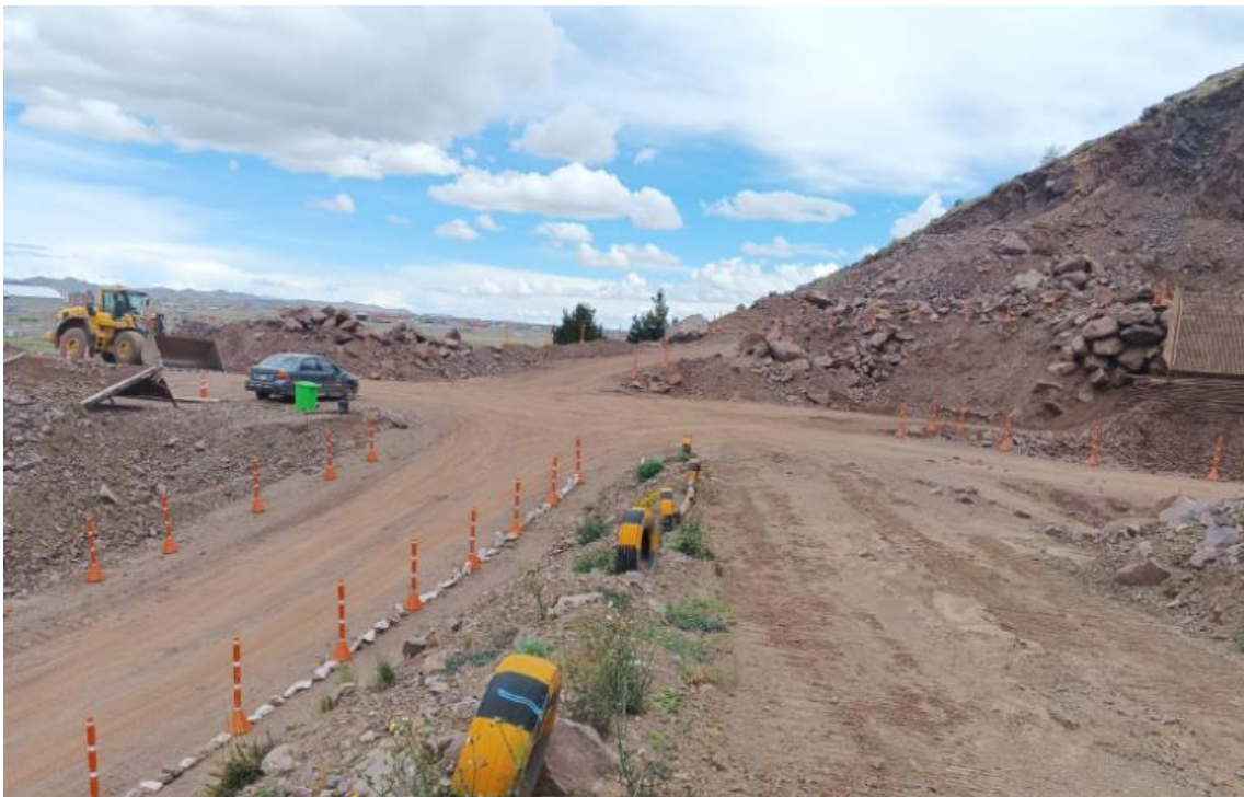
Fotografía 4. Señalización en vía.
