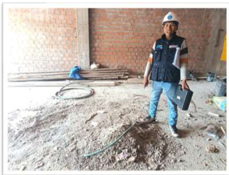
Registro de escombros
