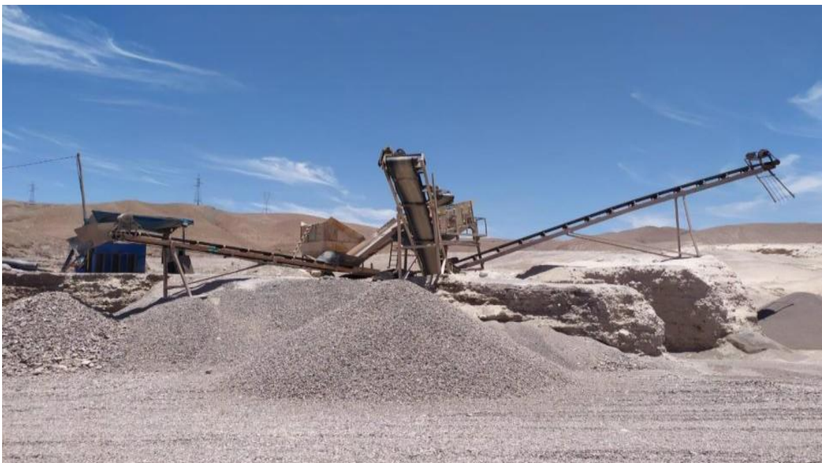
Planta de chancado y seleccionadora
