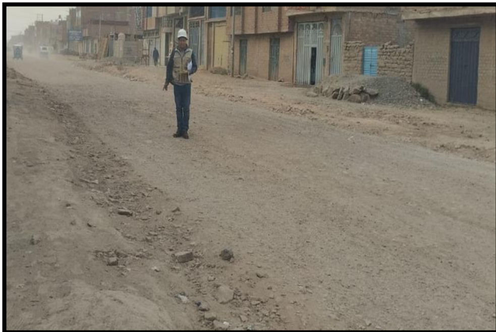
Fotografía 02: Ruta de red de drenaje
