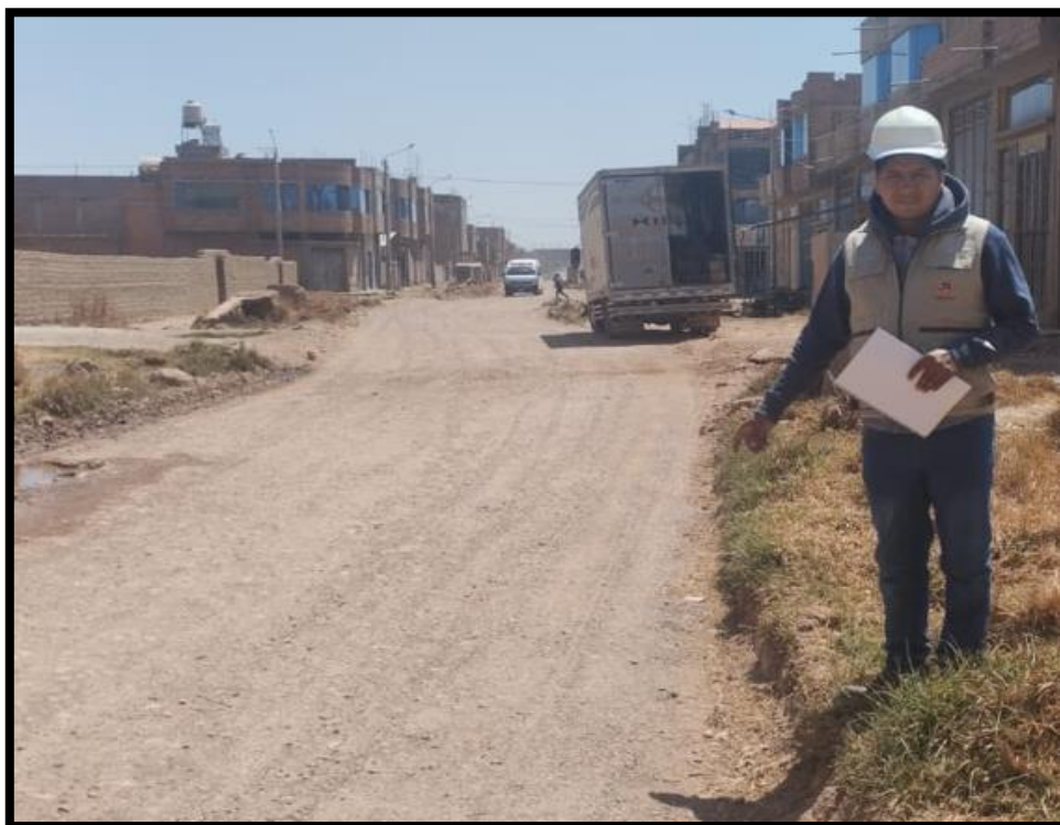
Fotografía 04: Tramo 2 red de drenaje
