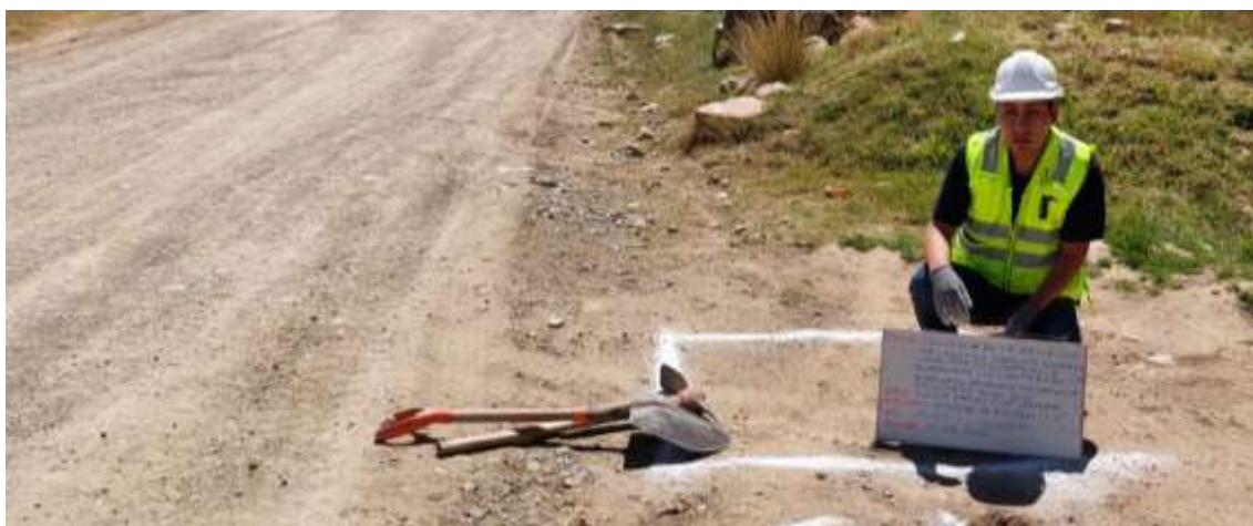
Fotografía 5. Vía 3: Lloquesani –Moho
