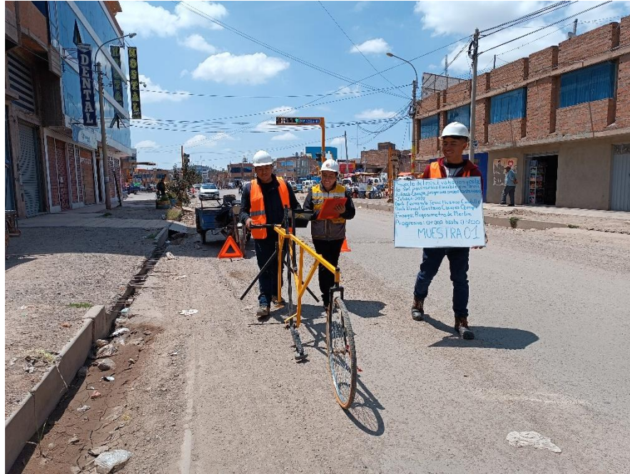
Ejecución del ensayo del rugosímetro de Merlin en progresiva 0+000 hasta 0+200 muestra 01
