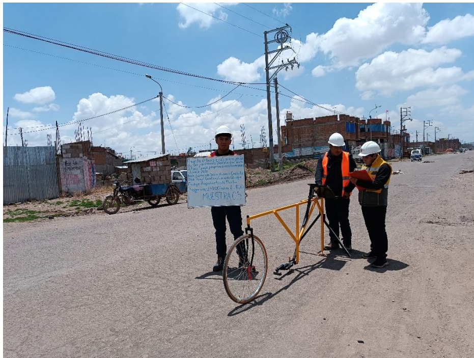
Toma de datos a medida que avanza el equipo en progresiva 2+700 hasta 2+900 muestra 05
