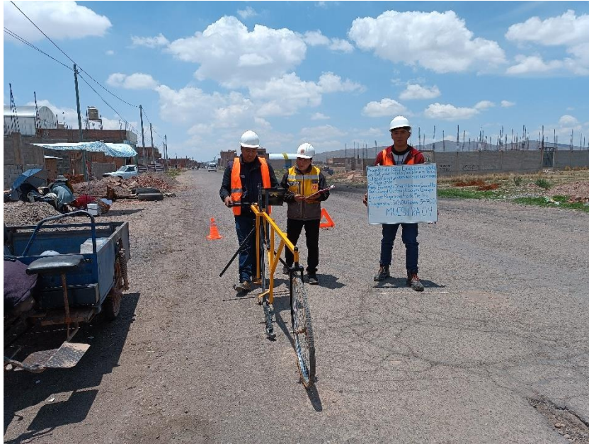
Ejecución del ensayo del rugosímetro de Merlin en progresiva 3+500 hasta 3+700 muestra 09
