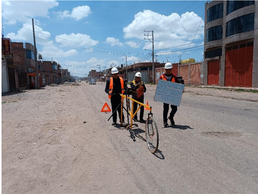
Ejecución del ensayo del rugosímetro de Merlin en progresiva 2+000 hasta 2+200 muestra 03
