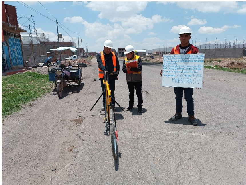
Toma de datos a medida que avanza el equipo en progresiva 3+500 hasta 3+700 muestra 09
