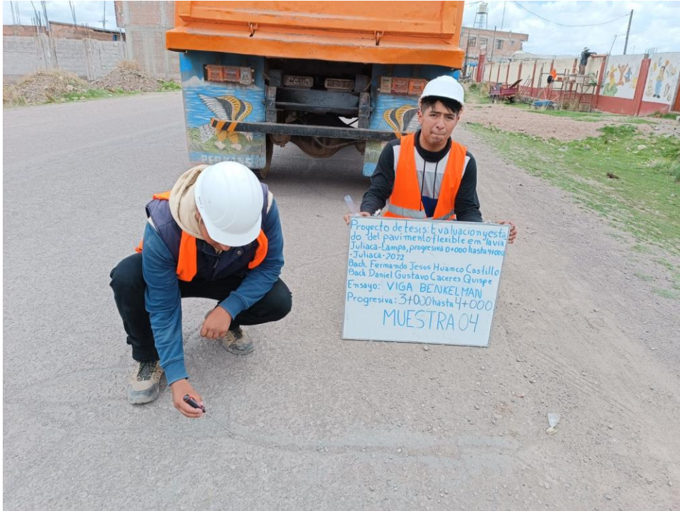
Lectura de la temperatura del pavimento flexible en la progresiva 3+000 hasta 4+000, muestra 04
