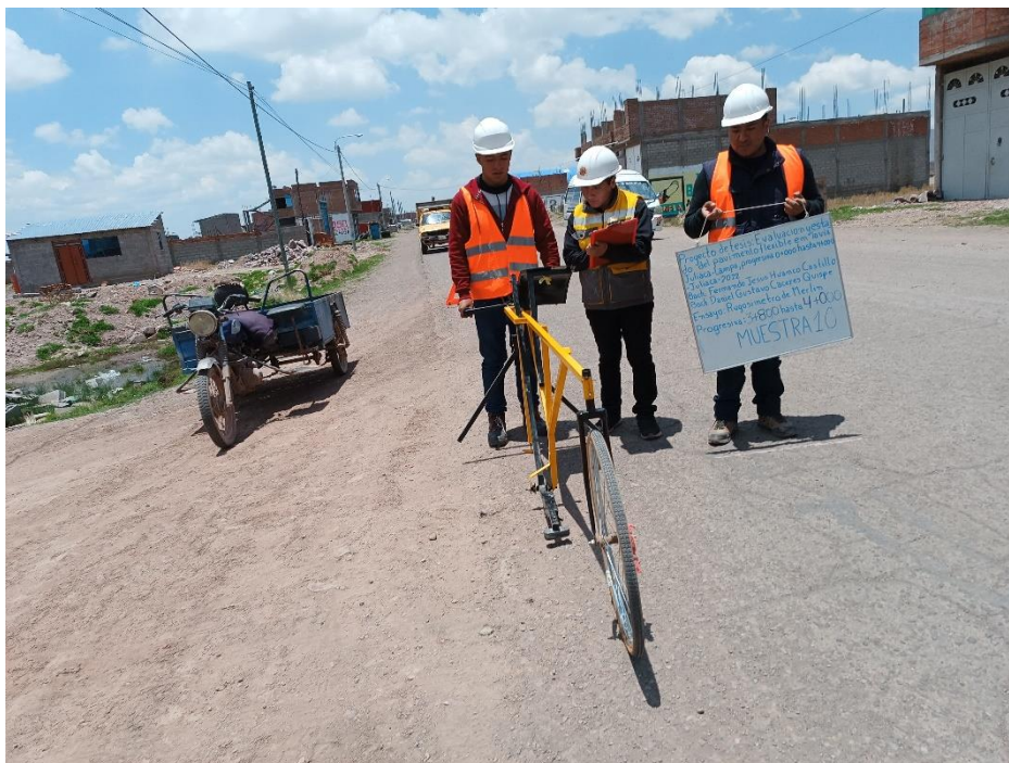
Toma de datos a medida que avanza el equipo en progresiva 3+800 hasta 4+000 muestra 10
