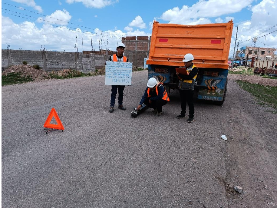
Posicionamiento y lectura de diales en la viga Benkelman progresiva 3+000 hasta 4+000, muestra 04
