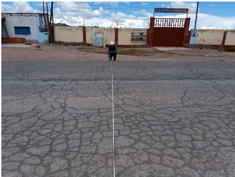
Medición de ancho de calzada 7.30m en punto final de estudio, vía Juliaca-Lampa.
