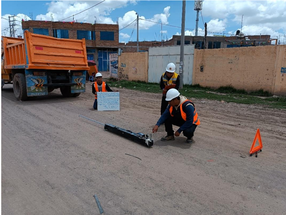
Lectura de diales en la viga Benkelman a medida que el volquete avanza progresiva 1+000 hasta 2+000, muestra 02
