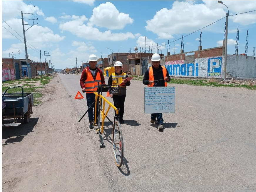
Ejecución del ensayo del rugosímetro de Merlin en progresiva 2+900 hasta 3+100 muestra 06
