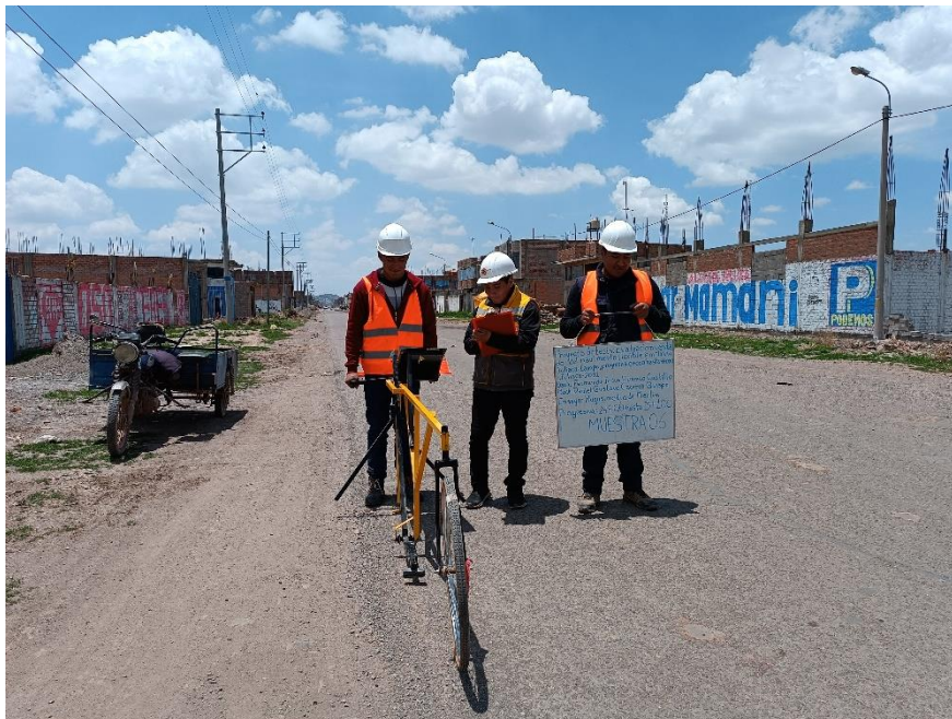
Toma de datos a medida que avanza el equipo en progresiva 2+900 hasta 3+100 muestra 06
