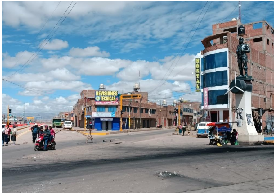
Punto de inicio de zona de estudio vía Juliaca-Lampa progresiva 0+000 hasta 4+000
