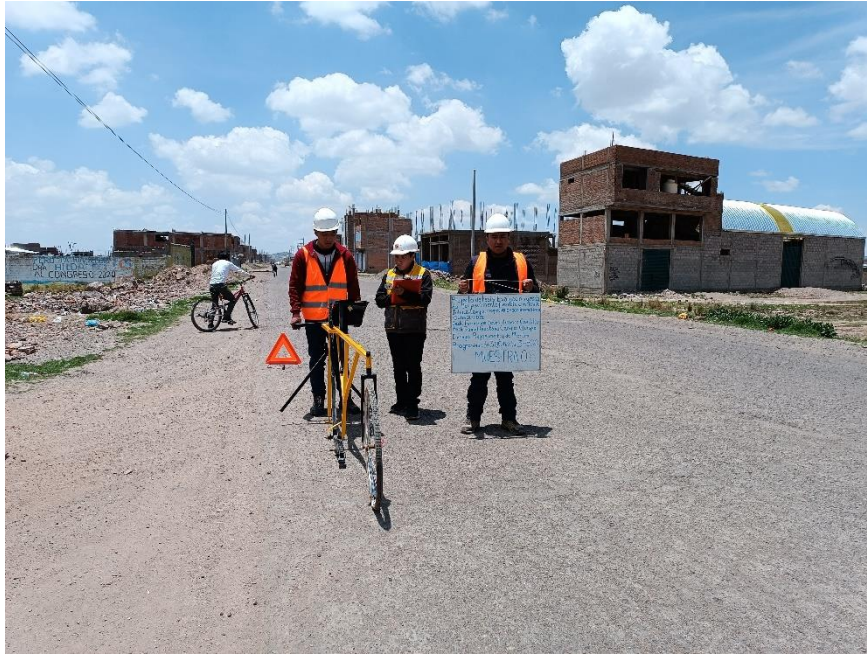
Ejecución del ensayo del rugosímetro de Merlin en progresiva 3+300 hasta 3+500 muestra 08
