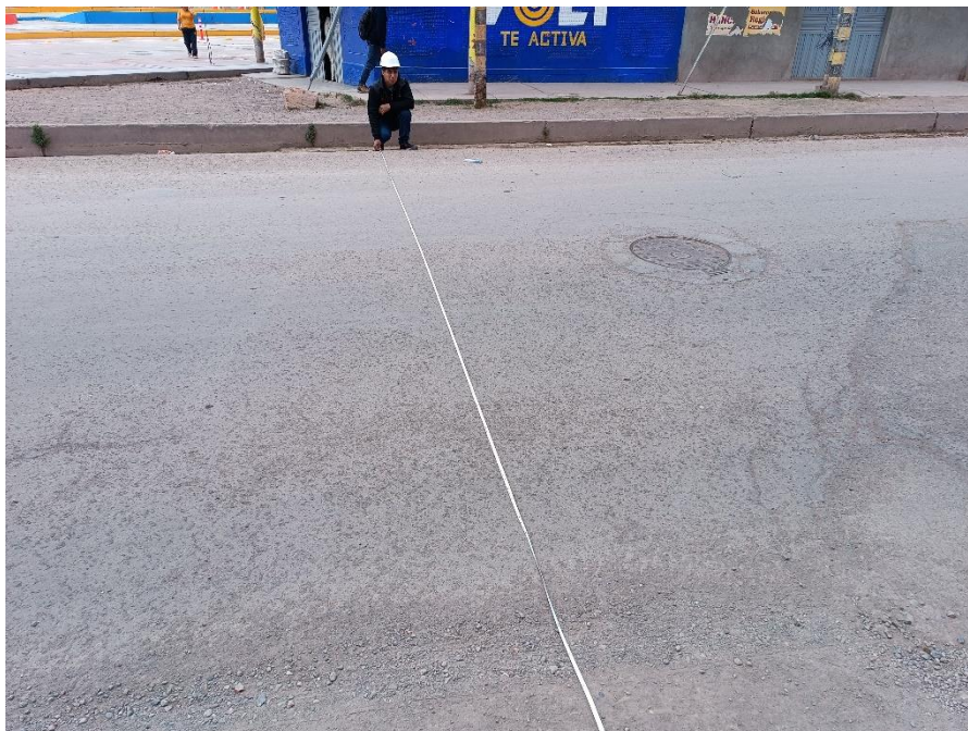
Medición de ancho de calzada en punto de inicio, vía Juliaca-Lampa
