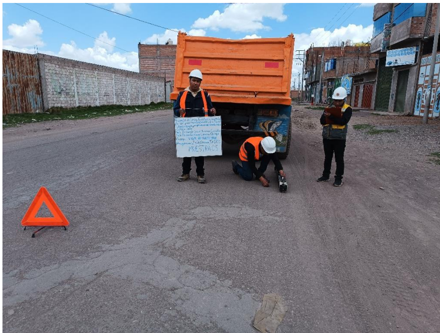
Posicionamiento y lectura de diales en la viga Benkelman progresiva 2+000 hasta 3+000, muestra 03
