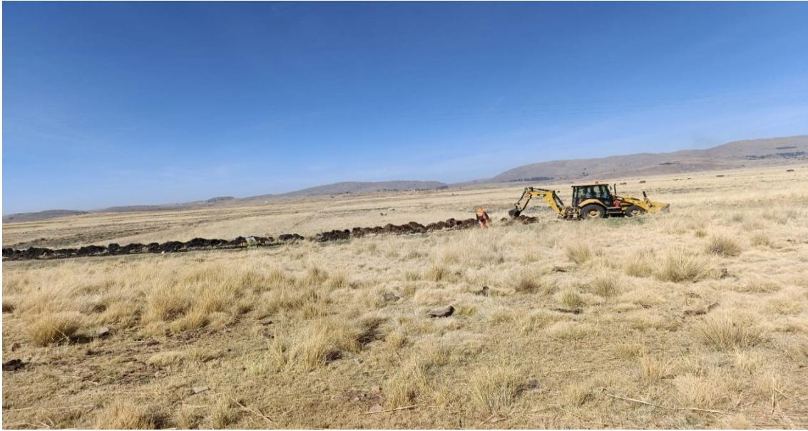
Fotografía 5. Proyecto en ejecución para la construcción de los sistemas de riego Huallatiri, Huayrapata y Huaranca Grande del Distrito de Huayrapata.
