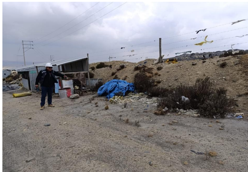
Fotografía 4. Estado actual del entorno perimetral de la zona de indumentaria de la Planta de Procesamiento Metalúrgico Rinconada.
