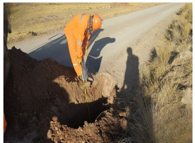
F-2 Realización de las calicatas
