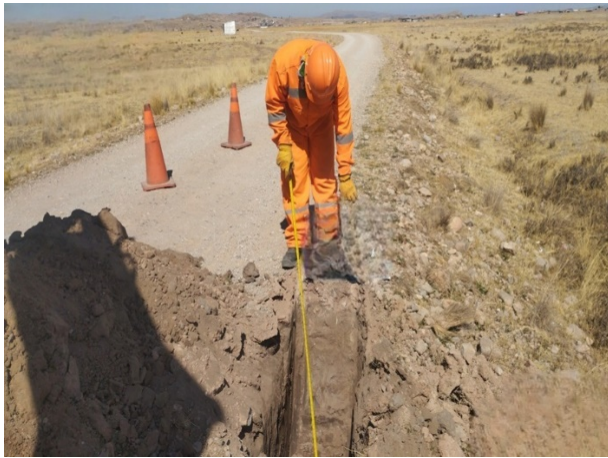
F-1 Realización de las calicatas
