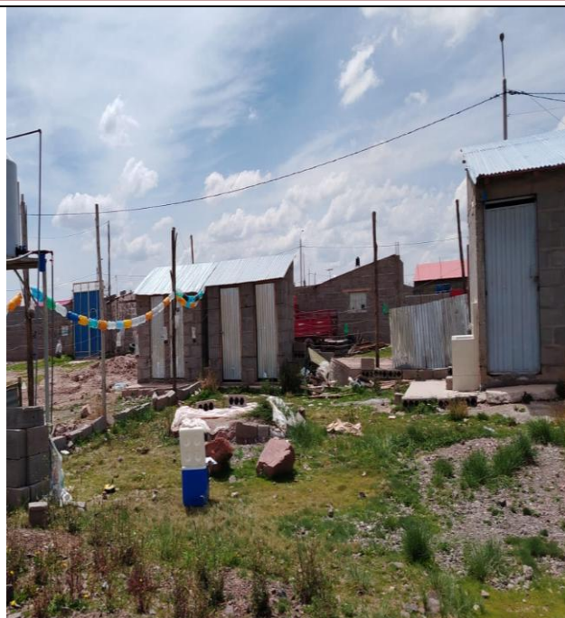
Imagen N° 6: se aprecia que algunos silos cuentan con casetas.
