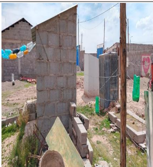
Imagen N° 5: se evidencia la proximidad de los silos con respecto a los domicilios.
