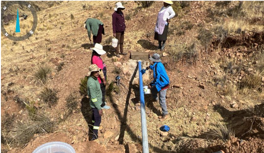
Fotografía 2: Pintado Línea De Conducción
