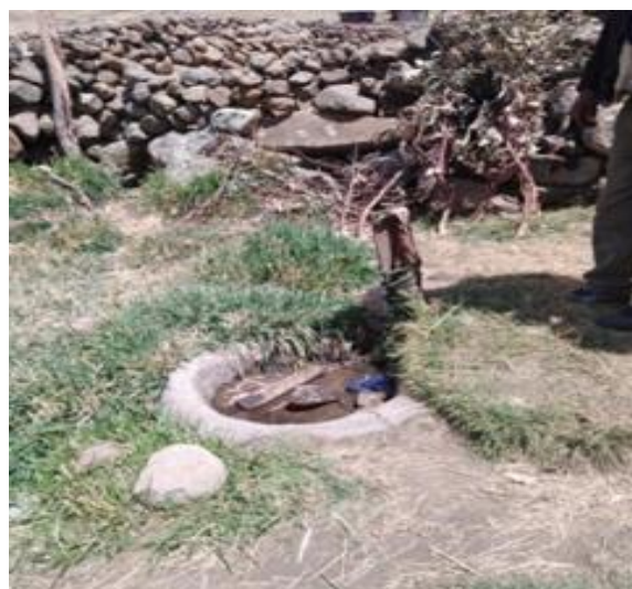
Figura 9 Pileta domiciliaria deteriorado
