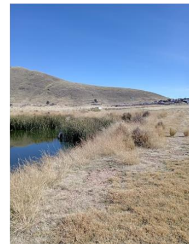
Barreras y Diques
