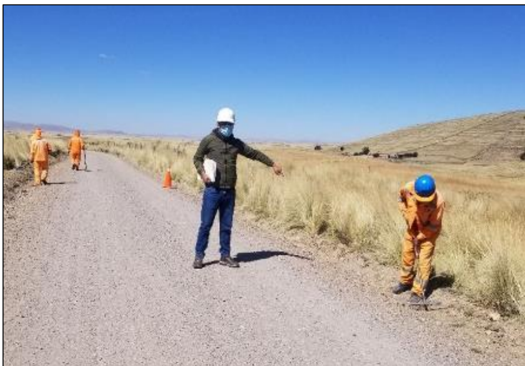
Fotografía 16. Tramo progresiva km 1+200
