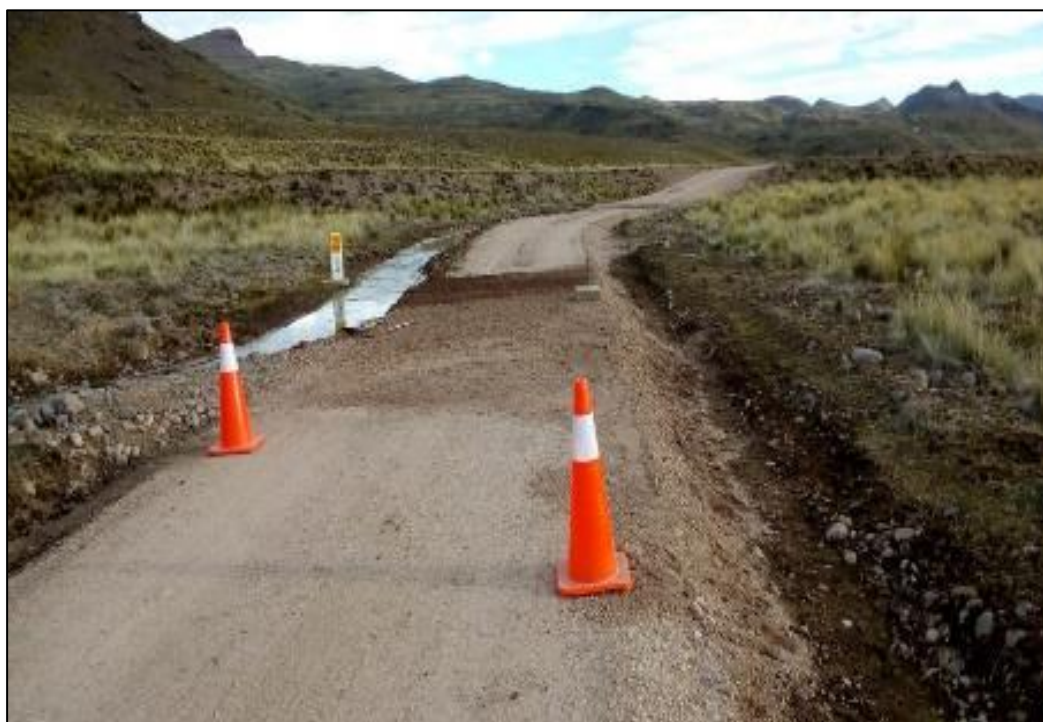
Fotografía 18. Tramo progresiva km 02+400
