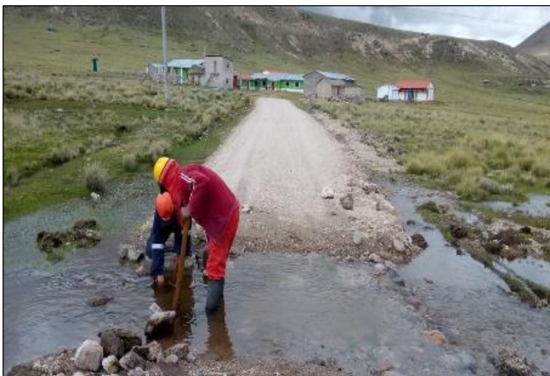
Fotografía 19. Tramo progresiva km 02+800
