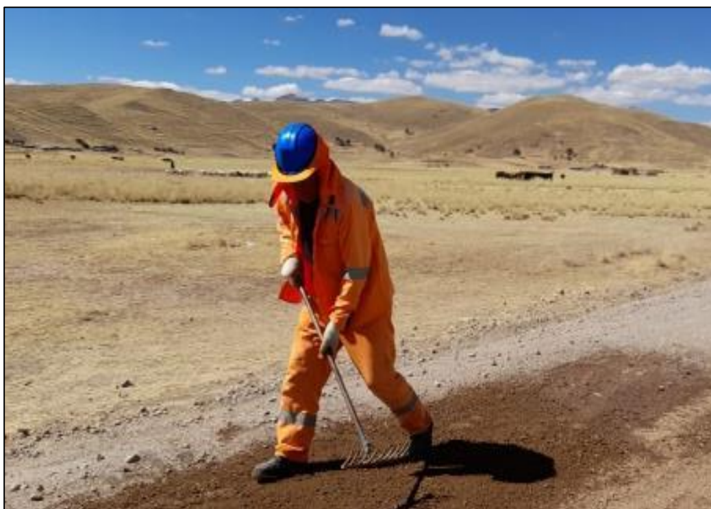
Fotografía 20. Tramo progresiva km 03+200
