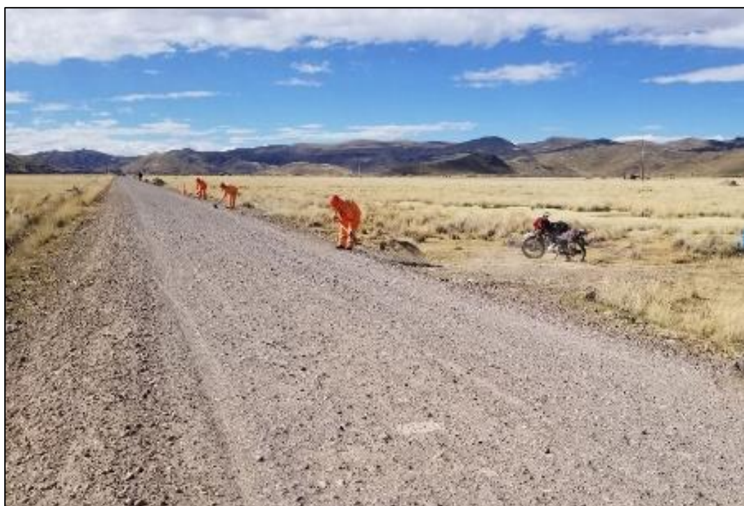
Fotografía 15. Tramo progresiva km 0+800
