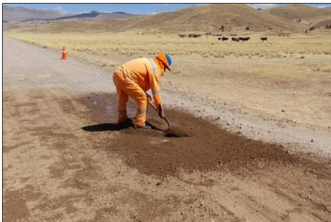
Fotografía 21. Tramo progresiva km 3+600
