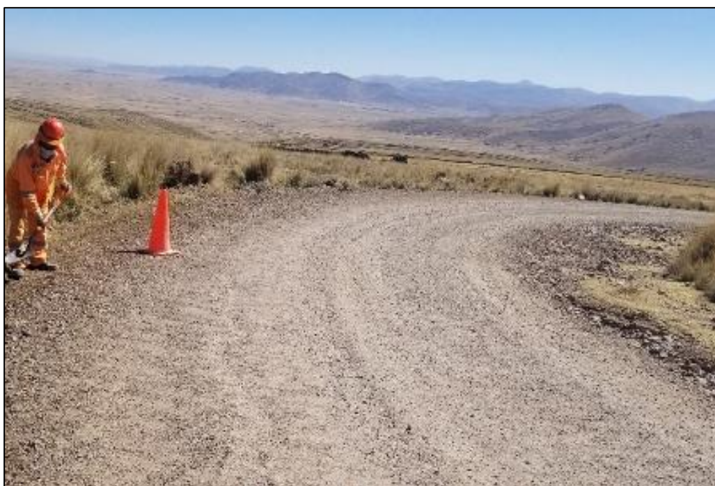
Fotografía 17. Tramo progresiva km 01+600
