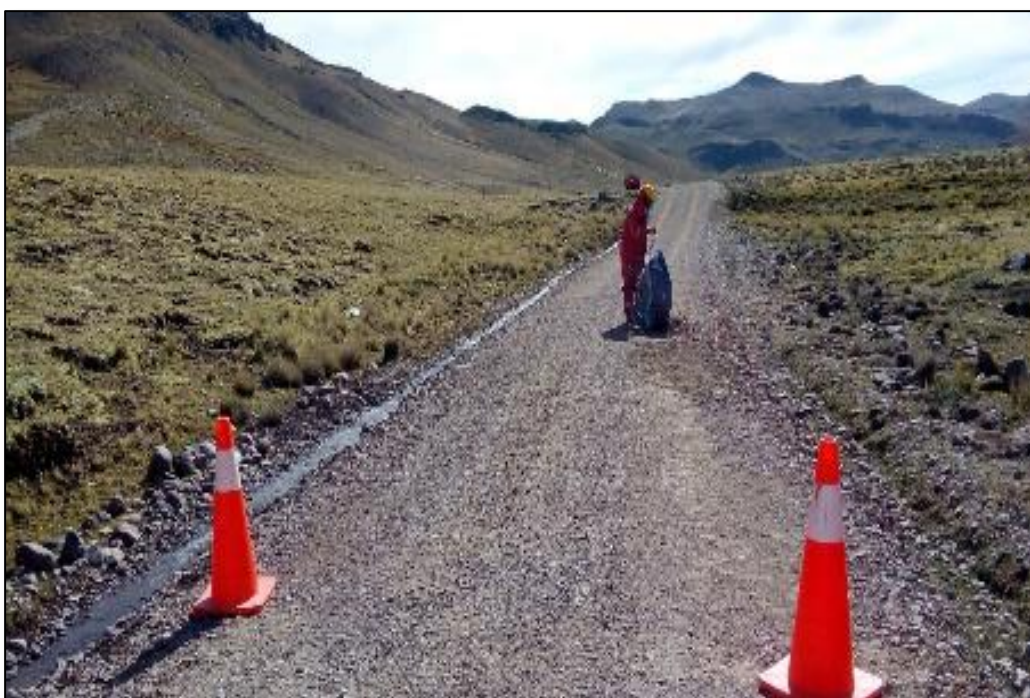
Fotografía 13. Tramo progresiva km 0+400
