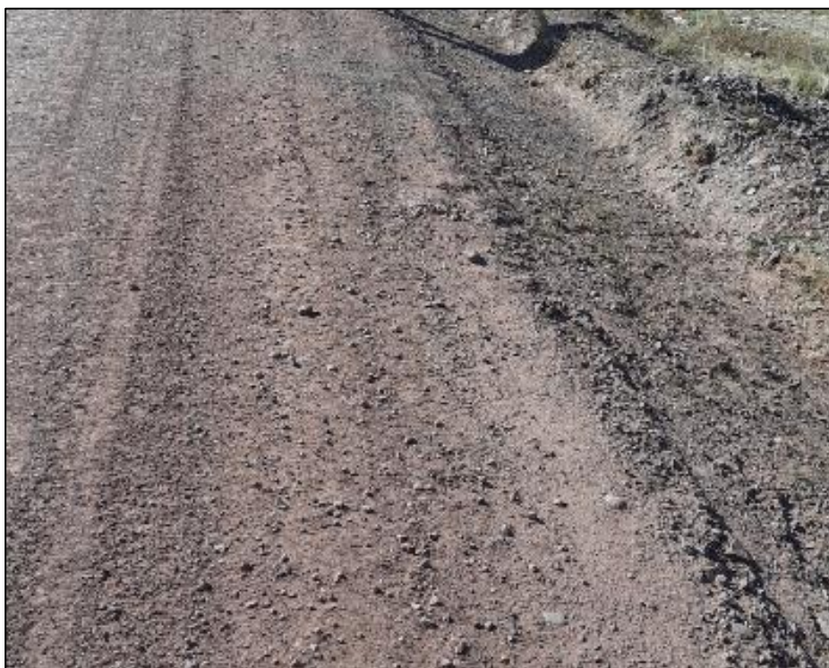
Fotografía 24. Vista de cunetas de la vía
