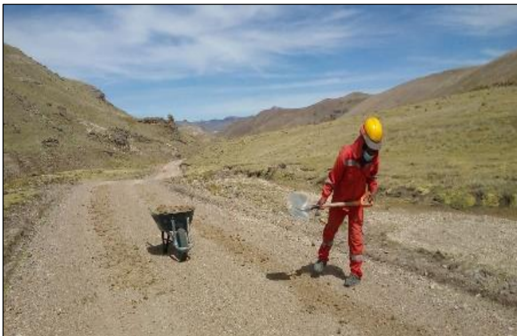
Fotografía 14. Tramo progresiva km 02+400
