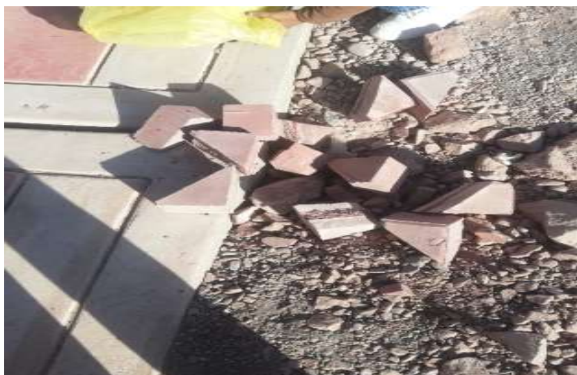
Fotografía 4. Desechos encontrados (restos de ladrillo) en la etapa constructiva de obras minimas (pista de un tramo) en el distrito de Juliaca.
