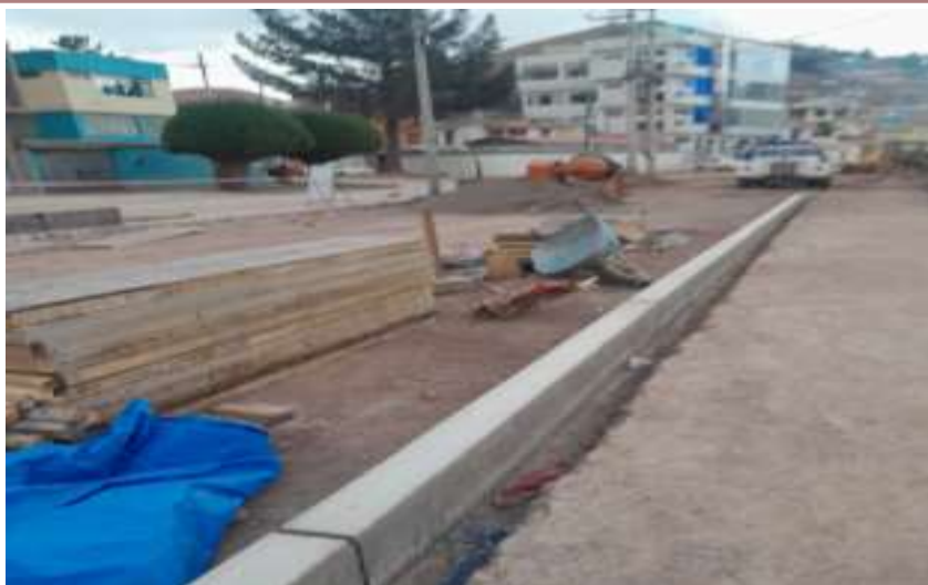
Fotografía 3. Situación actual de la etapa constructiva de obras minimas (pista de un tramo) en el distrito de Juliaca.
