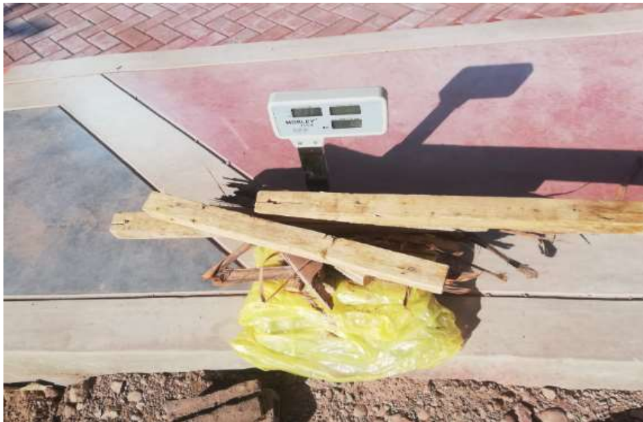
Fotografía 9. Pesaje de desechos (pedazos de madera inerte) en la etapa constructiva de obras minimas (pista de un tramo) en el distrito de Juliaca.
