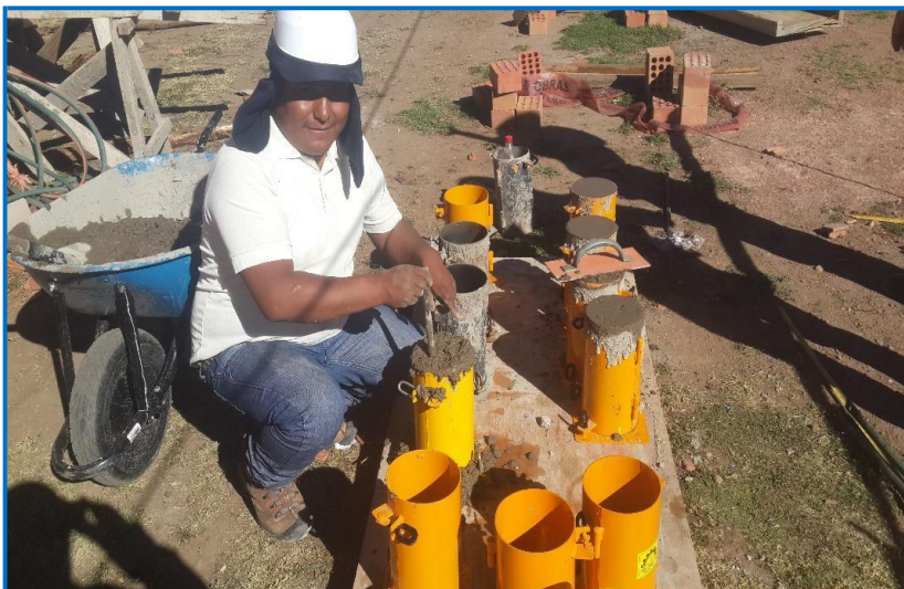
FOTOGRAFÍA 9. TRATAMIENTO DE BRIQUETAS DE CONCRETO
