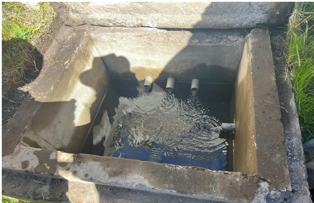
Figura 2. Visualización de la cámara de captación para la distribución de agua potable del sector Suma Pujo.
