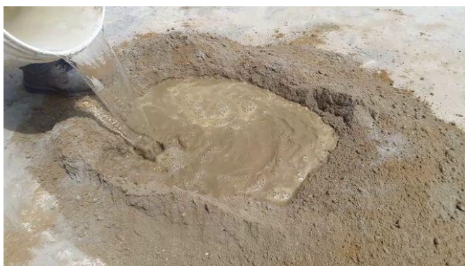
Agua para el concreto
