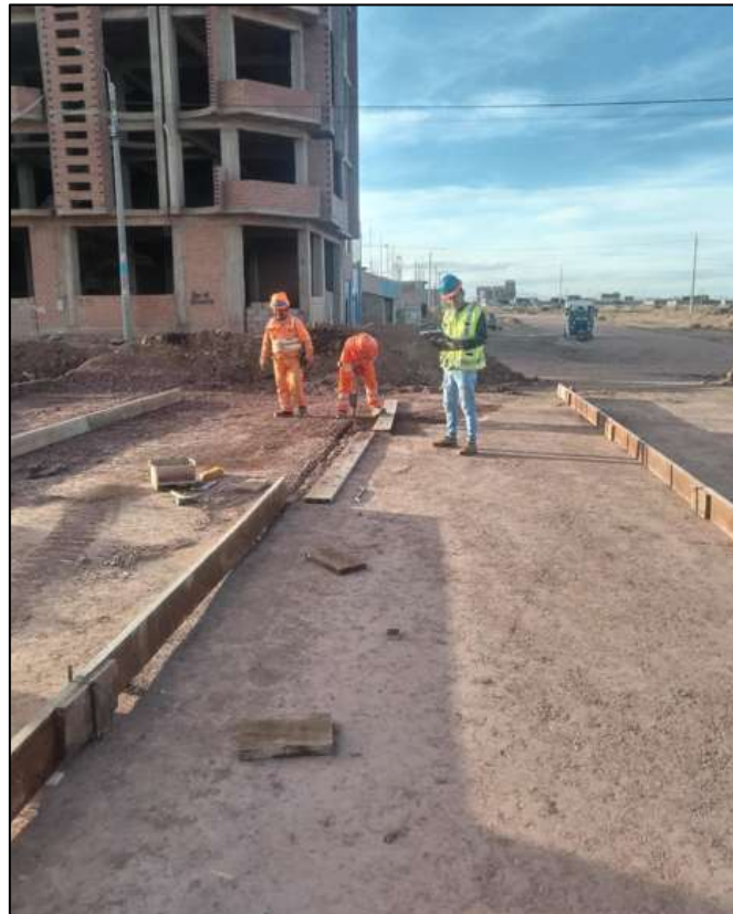
Fotografía N° 05: Control de rendimientos en encofrado de losa en la cuadra 8
