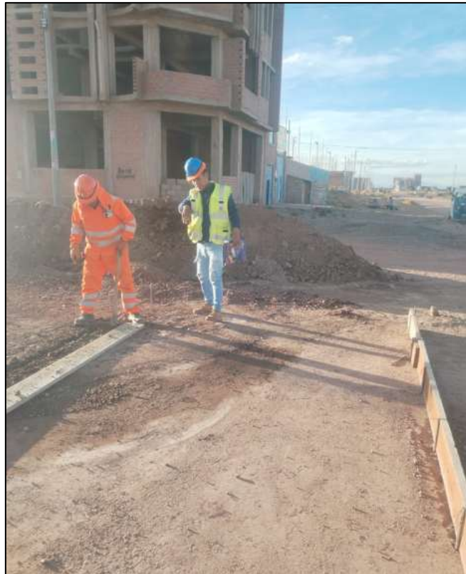
Fotografía N° 01. Control de rendimientos de trabajos de encofrado para losa
