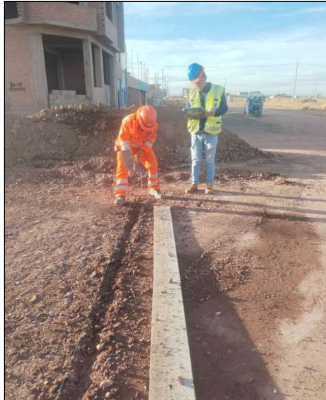
Fotografía N° 04: Control de rendimientos de colocación y armado de encofrados
