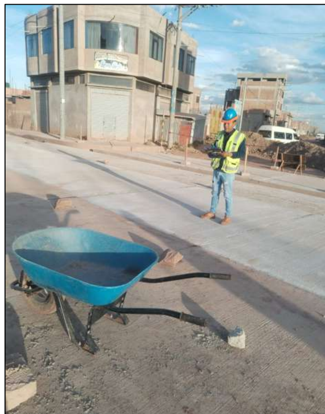
Fotografía N° 03: Control de rendimientos de trabajos de limpieza del terreno
