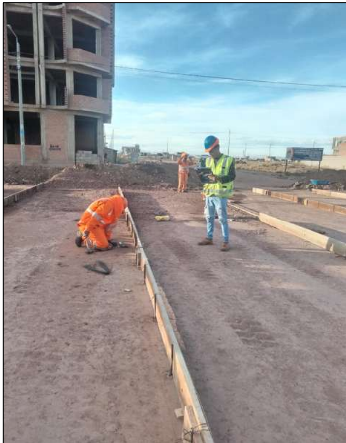
Fotografía N° 12: Control de rendimientos de trabajos en asegurar el encofrado cuadra 5
