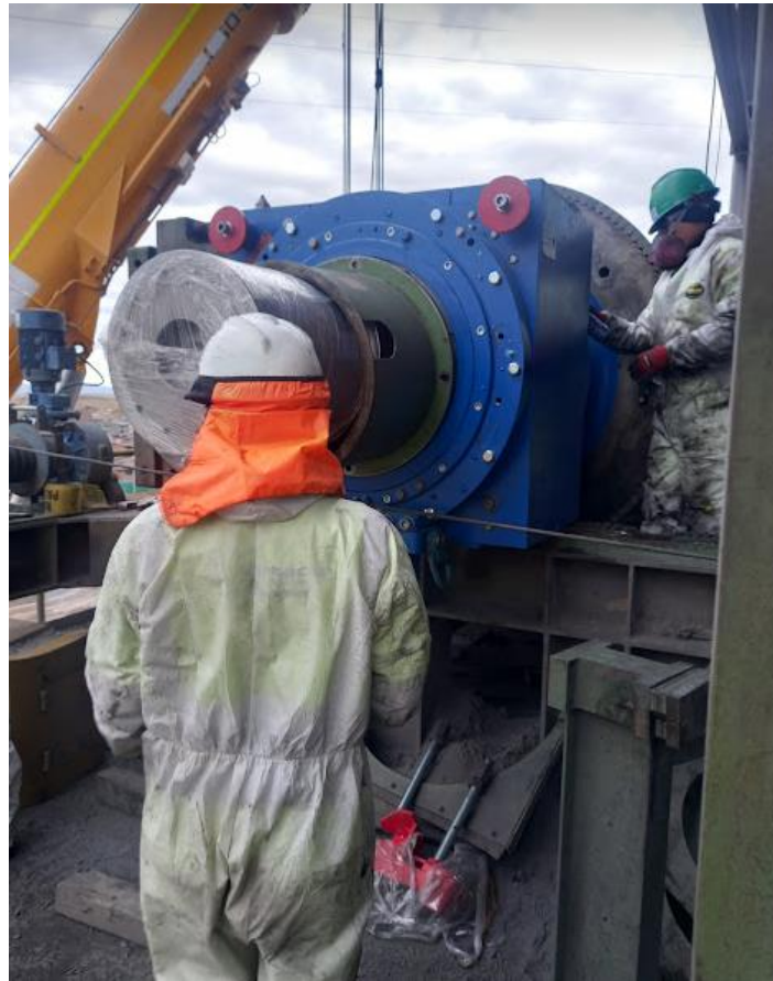
Foto (03): Montaje HPGR 100 TN
