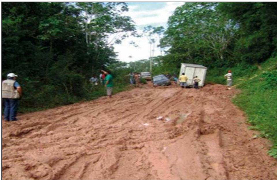
Figura 1. Vías del Perú en mal estado. Tomada de «Problemática y soluciones carreteras rurales», por Vialidad y Transporte Latinoamericano. 2016, p. 50.
