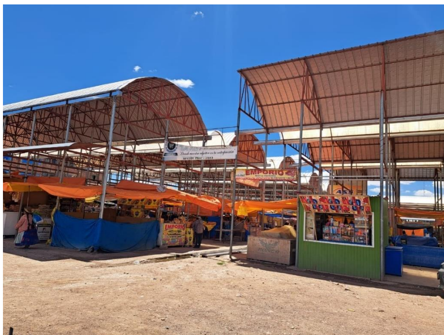
Vista de la infraestructura metálica del Mercado
