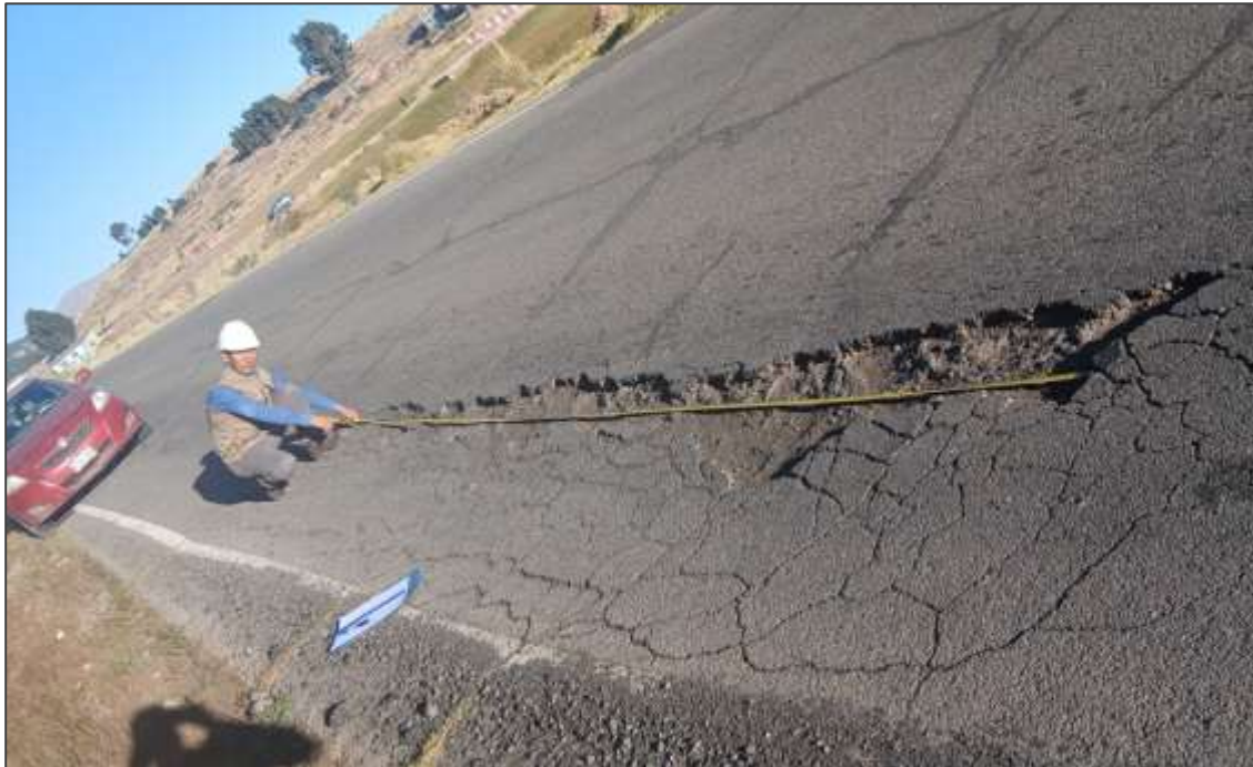
Fotografía N° 15: Tipo de falla ahuellamiento con desprendimiento de agregados en severidad alta
