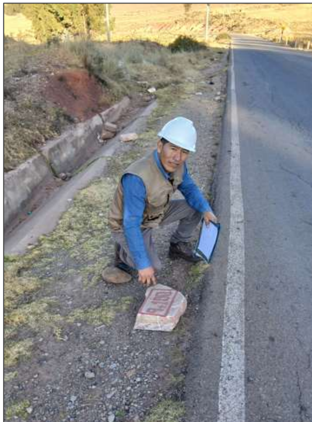
Fotografía N° 06: Verificación de las unidades de muestra mediante la progresiva
