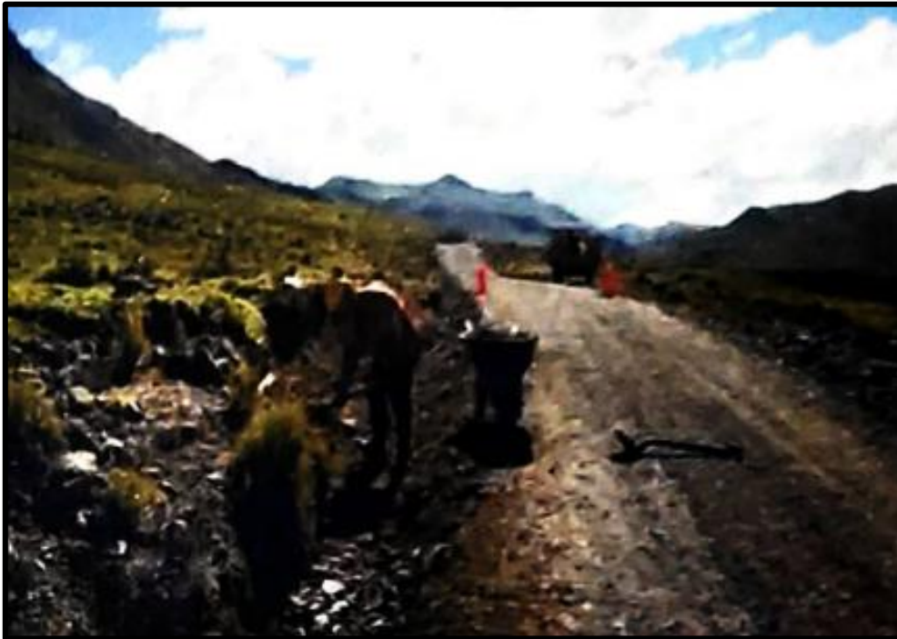
Fotografía 13. Tramo progresiva km 05+700
