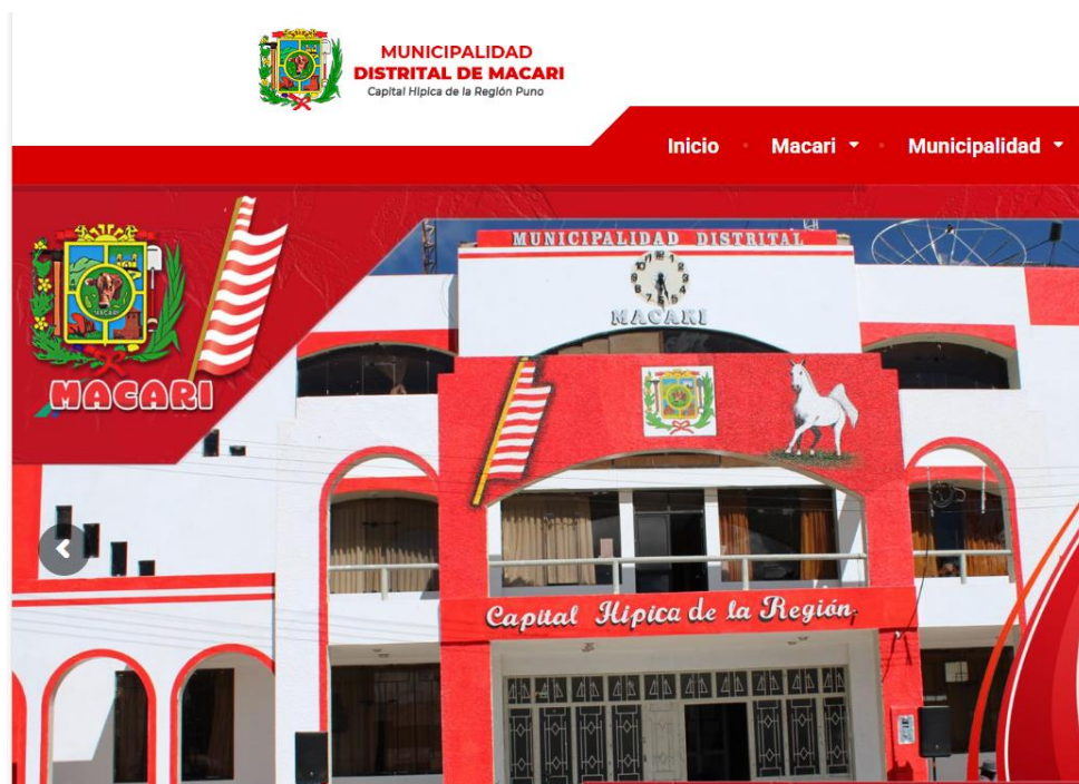
Vista de la fachada de la Municipalidad de Macarí
