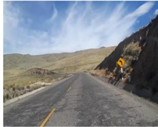
Fotografía 04: Identificación del tramo de concentración de accidente N°03.
