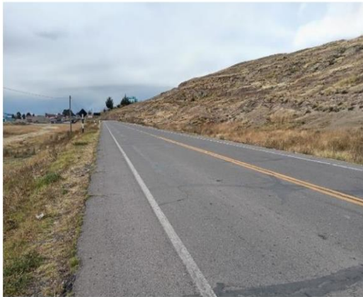
Fotografía 15: Identificación del tramo de concentración de accidente N°14.
