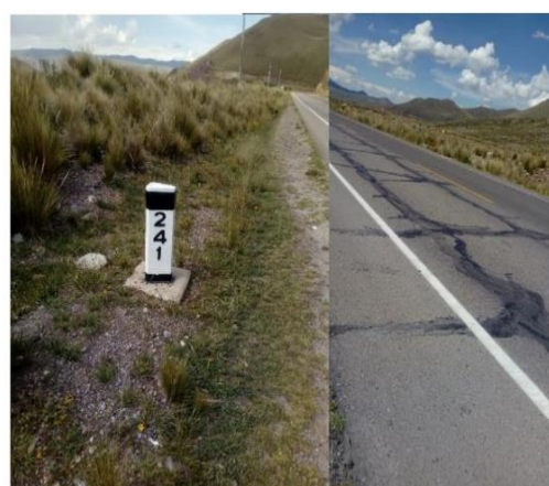
Fotografía 12: Identificación del tramo de concentración de accidente N°11.
