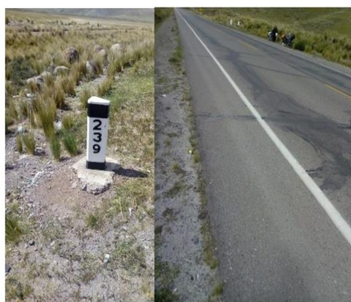
Fotografía 11: Identificación del tramo de concentración de accidente N°10.
