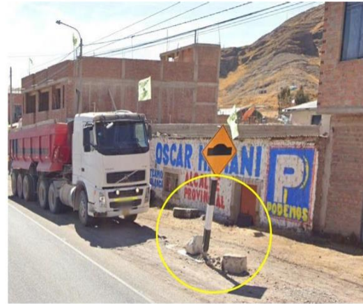
Fotografía 20: La señalización vertical tipo P-33A presenta daños en la base.
