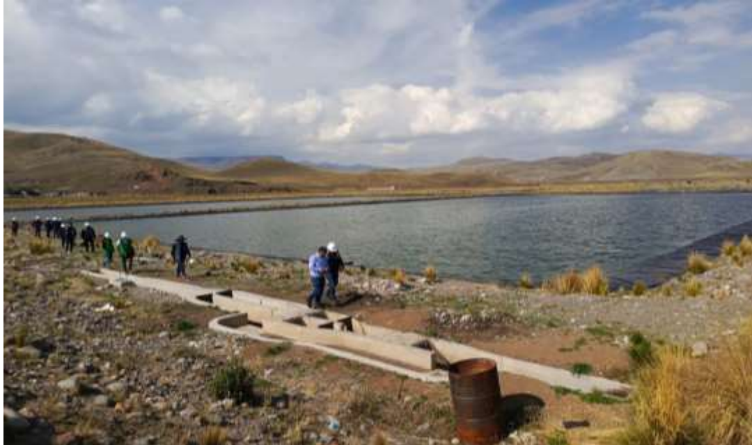
Fotografía 1. Unidad de pretratamiento de aguas residuales en la PTAR Santa Lucía.
