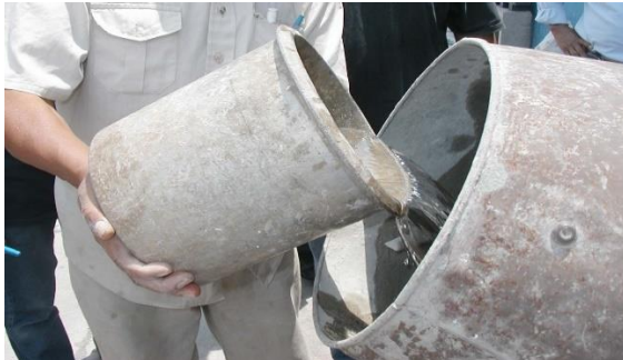
Agua para el concreto
