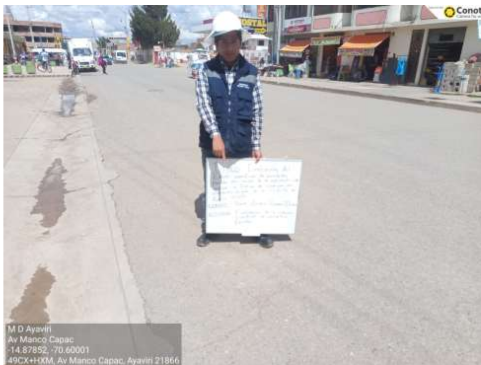
Fotografía 16. Desnivel carril / berma en severidad media en Av. Manco Capac
