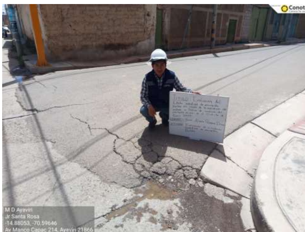
Fotografía 2. Piel de cocodrilo en severidad alta en Jr. Santa Rosa
