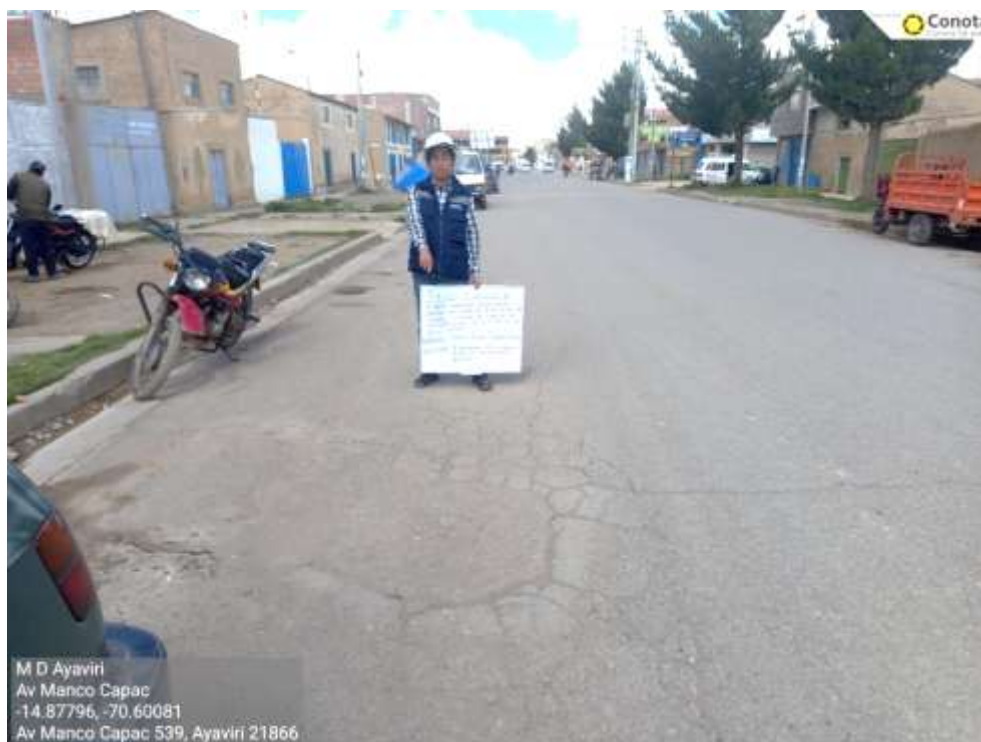
Fotografía 24. Piel de cocodrilo y parcheo en severidad media en Av. Manco Capac
