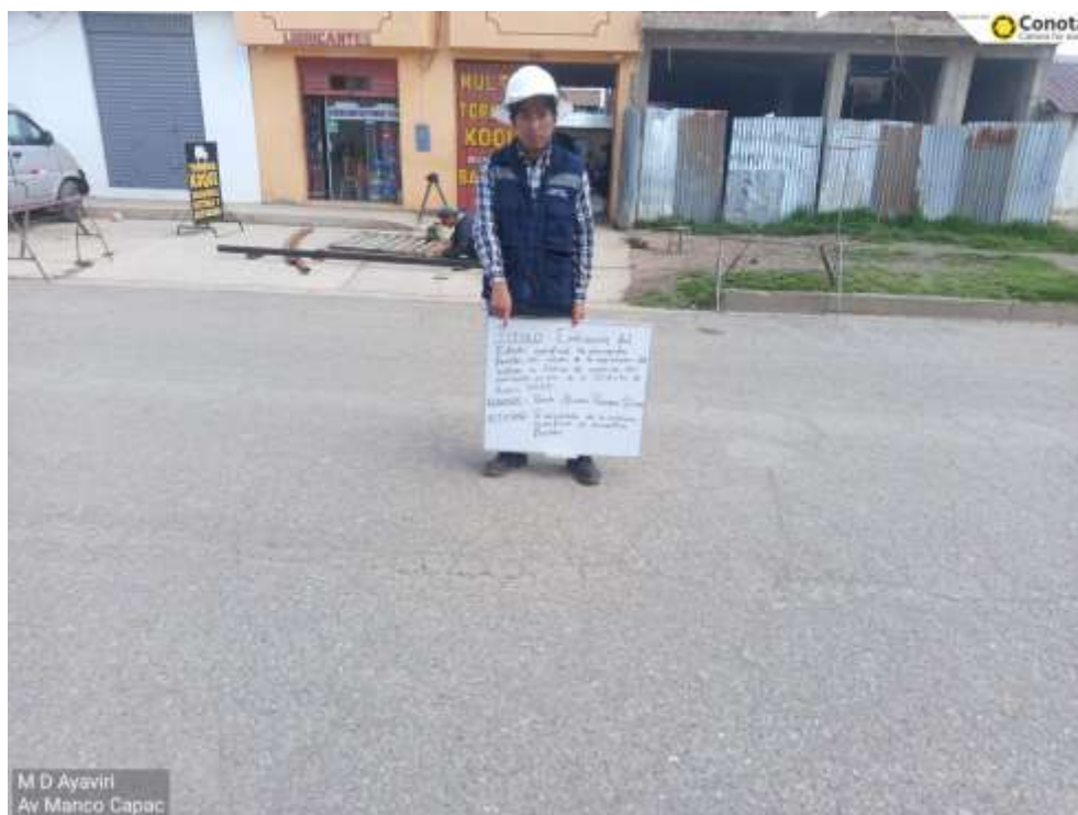
Fotografía 26. Fisuras long. / transv. en severidad media en Av. Manco Capac
