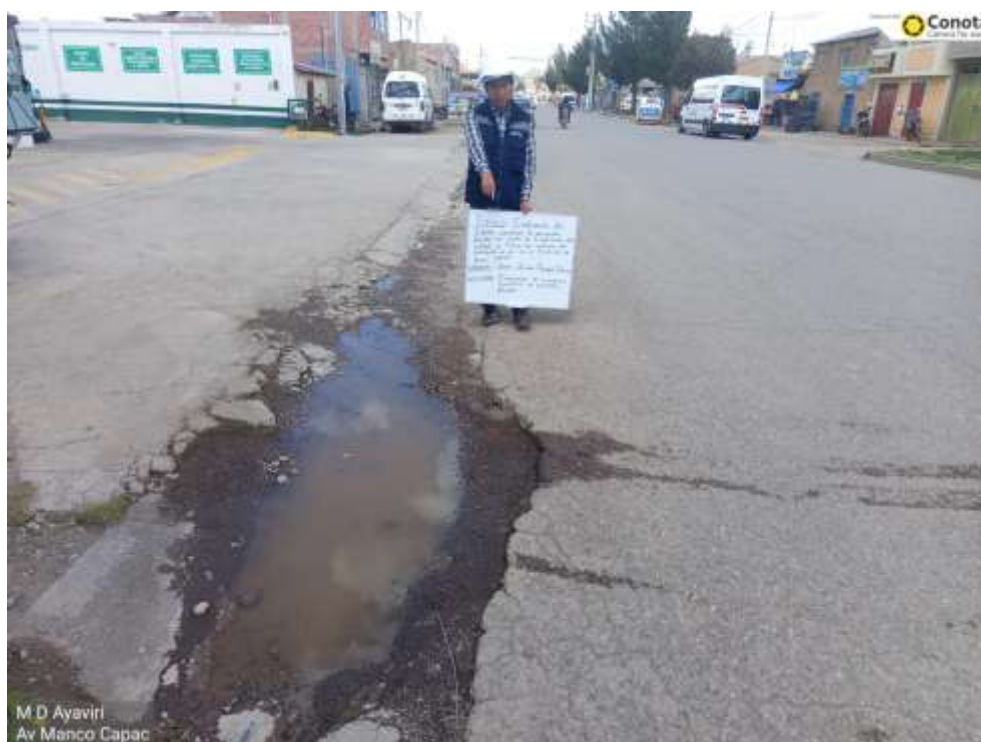
Fotografía 25. Grieta de borde en severidad alta en Av. Manco Capac
