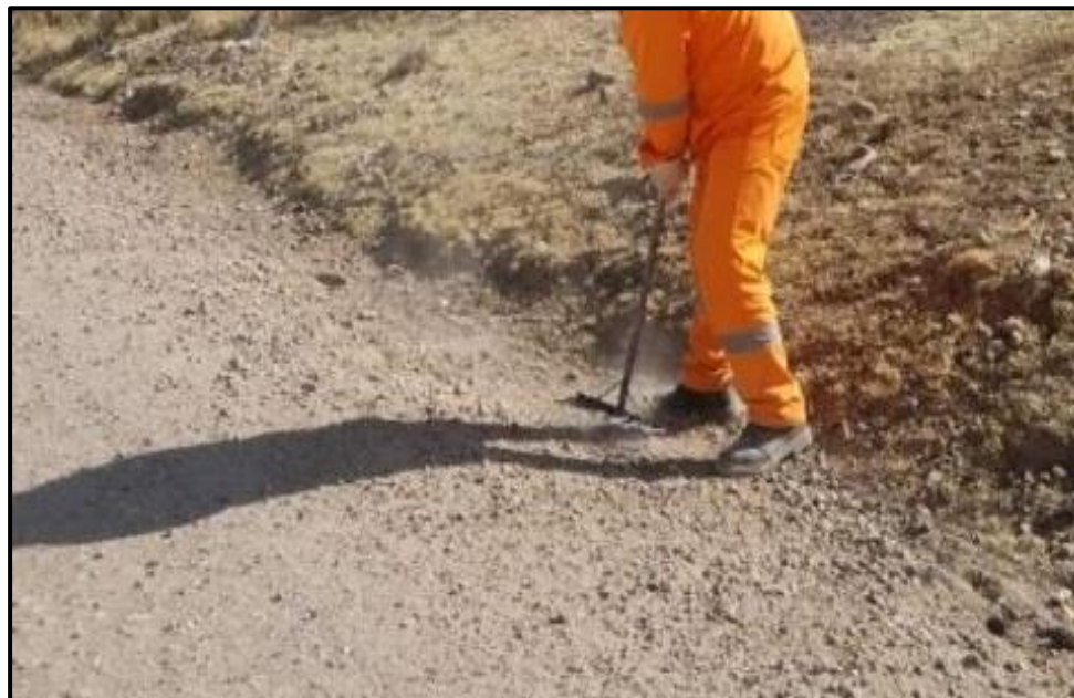
Fotografía 8. Tramo progresiva km 03+700 Limpieza de cunetas
