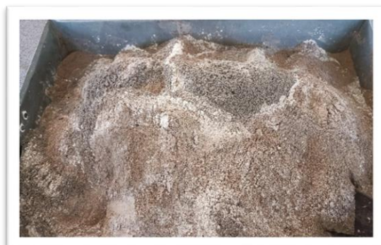
Mezclado de suelo cal y CCQ
