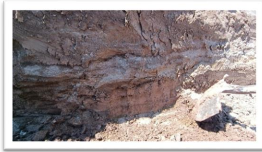
Excavación de la calicata
