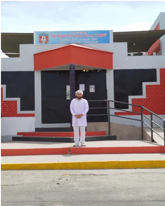
FOTO 1: Puerta principal de la IE. Víctor Raúl Haya de la Torre.
